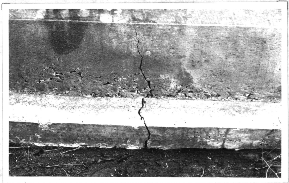
รูปที่ 4.13 ข. ลักษณะและตำแหน่งการแตกหักของคานคอดินที่ใช้ในการทดลอง
