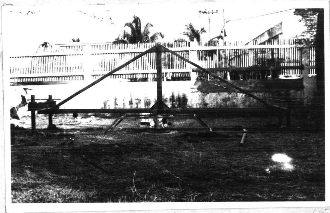
รูปที่ 4.1 ก. การทดลอง Plate Load Test
