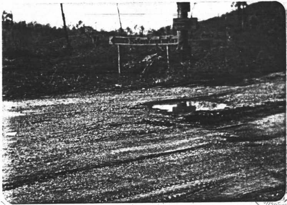
รูปที่ 6.1 แสดงแนวท่อส่งน้ำวางลอคผ่านถนนที่มีรถวิ่งผ่านเป็นประจำ ซึ่งมีการแตกชำรุดเกิดขึ้นบ่อย ๆ
