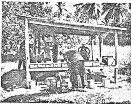
ภาพที่ 2.3 โรงทำยางง่าย ๆ ไม่ต้องใช้วิศวกร ชนิด คนเดียวก็ทำได้ มีที่กรองอย่าง ดี ถึงผสมน้ำยาง ตะก่ง เครื่องรีตยาง ทผงยาง มีบ่อน้ำเป็นใช้ได้ ตามภาพ เจ้าของสวนยางกำลังกรองน้ำยาง
