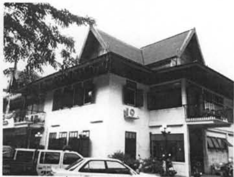
ภาพที่ 3.28 สถานีตำรวจพระโขนง (ที่มา : จากการสำรวจ, 2549)
