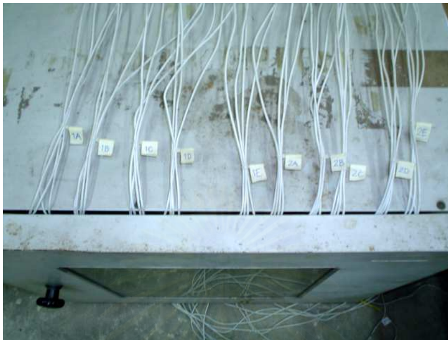
รูปที่ 6.10 การวางสายไฟทความร้อนเข้าสู่เตาอบอุณหภูมิ
