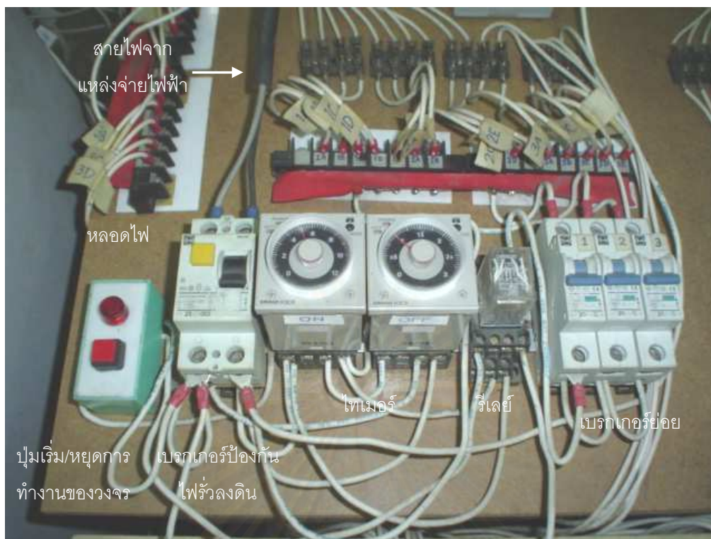
รูปที่ 6.7 วงจรควบคุมทางด้านปฐมภูมิที่ต่อจากแหล่งจ่ายไฟฟ้า
