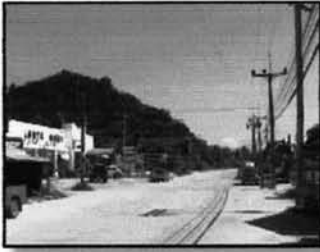
สภาพถนนบริเวณบ้านศาลาด่าน
