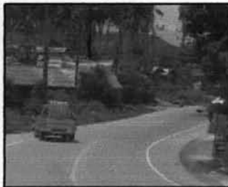
สภาพถนนบริเวณด้านหน้าสถานประกอบการ RAWI
