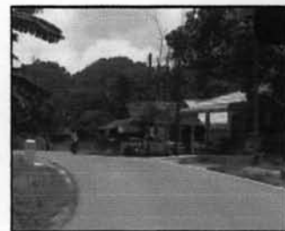
สภาพถนนบริเวณบ้านคลองนิน
