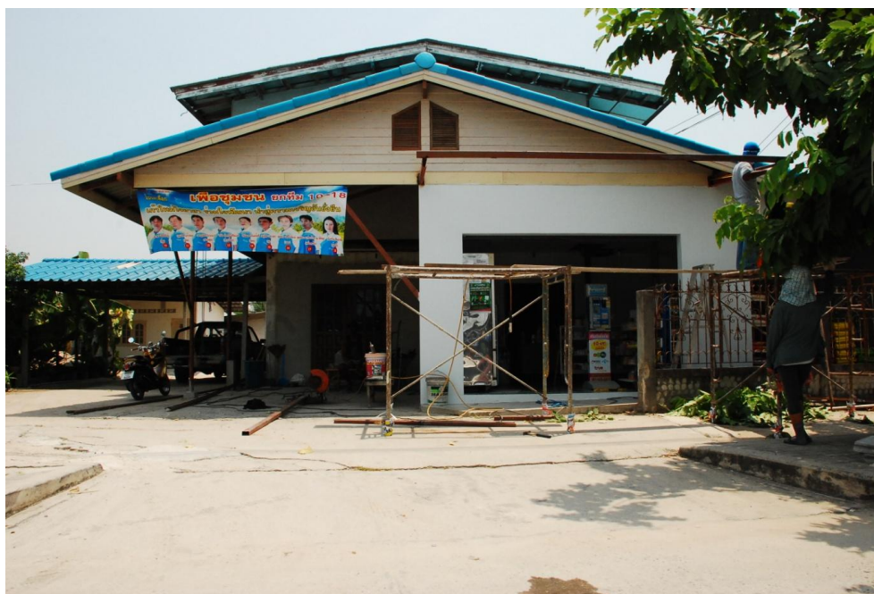
รูปที่ 5.16 ลักษณะบ้านทั่วไปในชุมชนที่มีการต่อเติม
