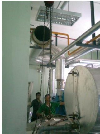
ภาพที่ 4.9 การใช้รอกโซ่ ยกขึ้นไปตรงตำแหน่งที่ติดตั้ง
