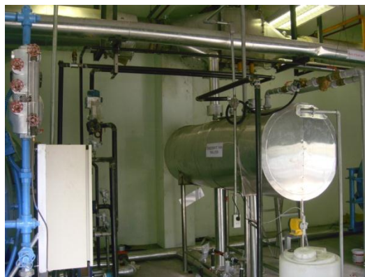
ภาพที่ 4.11 หม้อไอน้ำหลังติดตั้งอีโคโนไมเซอร์
