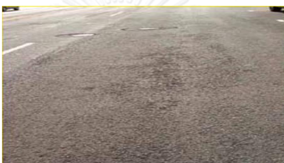
ภาพที่ 2.5 การสึกกร่อนบนผิว
