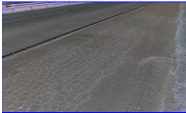
ภาพที่ 2.1 รอยแตกแบบหนังจระเข้หรือรอยแตกจากการล้า
