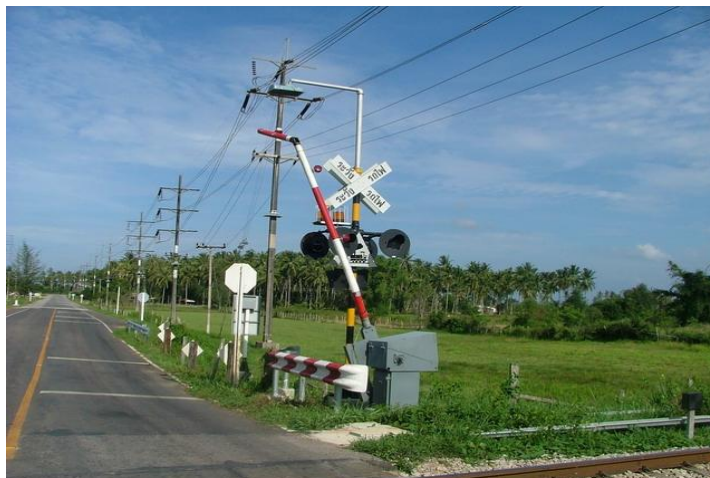
รูปที่ 2. 2 ประตูกั้นทางรถไฟแบบอัตโนมัติ
