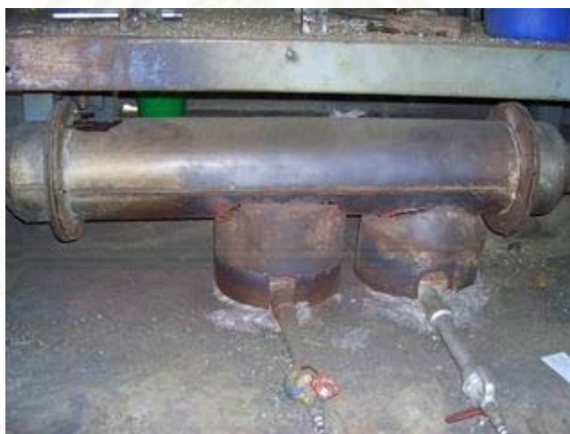
รูปที่ 3.11 ตัวให้ความร้อนอากาศก่อนเข้าเตาเผา (air preheater)
