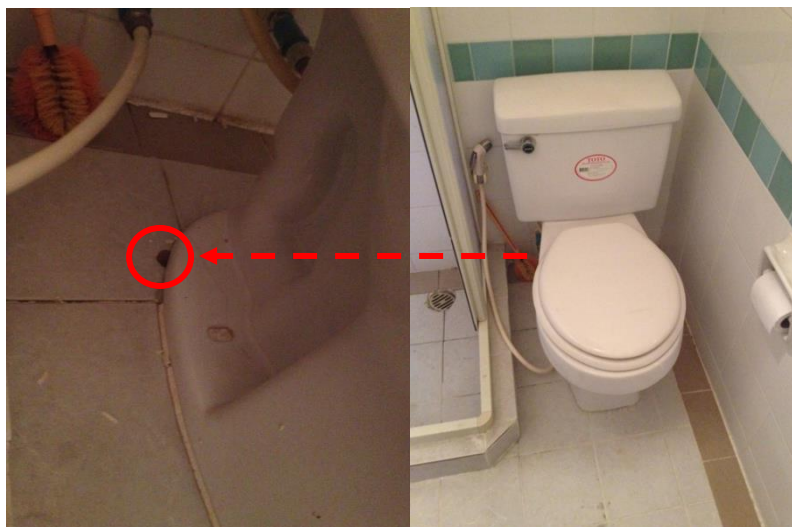
แผนภาพที่ 5.2 การเจาะรูระบายอากาศชักโครก
