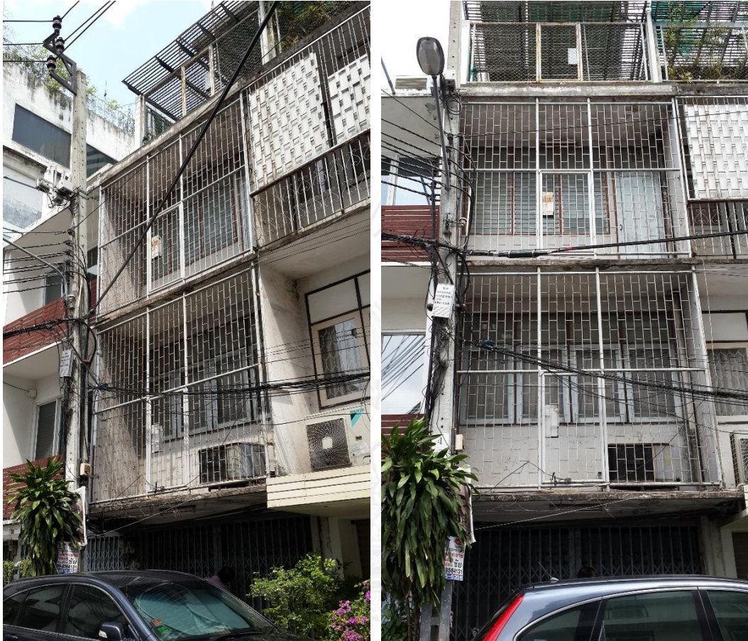
ภาพที่ 22 หน้าอาคารตึกแถวที่ทำการสำรวจ (บ้านเลขที่ 53 ซอยเจริญนคร 13 ถนนเจริญนคร เขตคลองสาน แขวงคลองตันไทร กทม. 10600)
