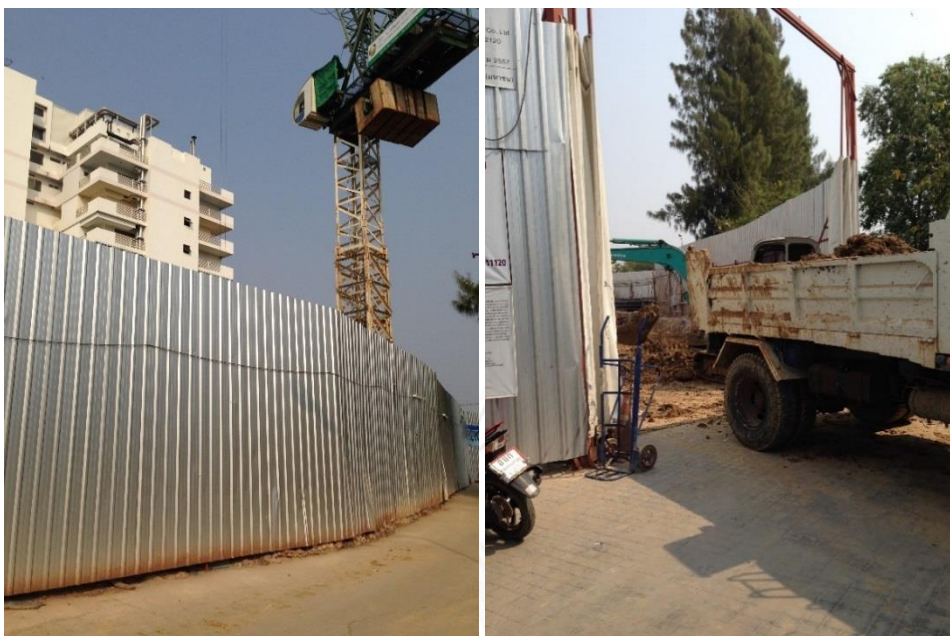
ภาพที่ 28 การกั้นพื้นที่ก่อสร้างโรงพยาบาลกรุงเทพราชสีมา
