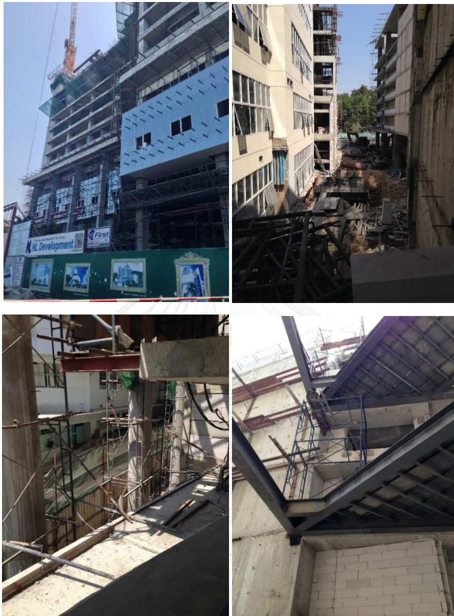
ภาพที่ 20 พื้นที่ก่อสร้างอาคารต่อขยายโรงพยาบาลสมิติเวช ศรีราชา
