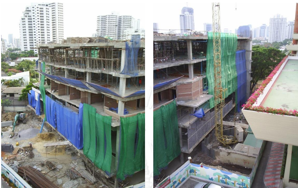
ภาพที่ 13 การป้องกันฝุ่นละอองและวัสดุร่วงหล่นโรงพยาบาลสมิติเวช สุขุมวิท
