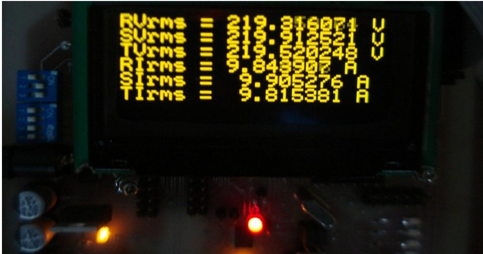
รูปที่ 5—14 วัดค่ากระแสสลับแอมแปร์ แรงดัน 220 โวลต์
