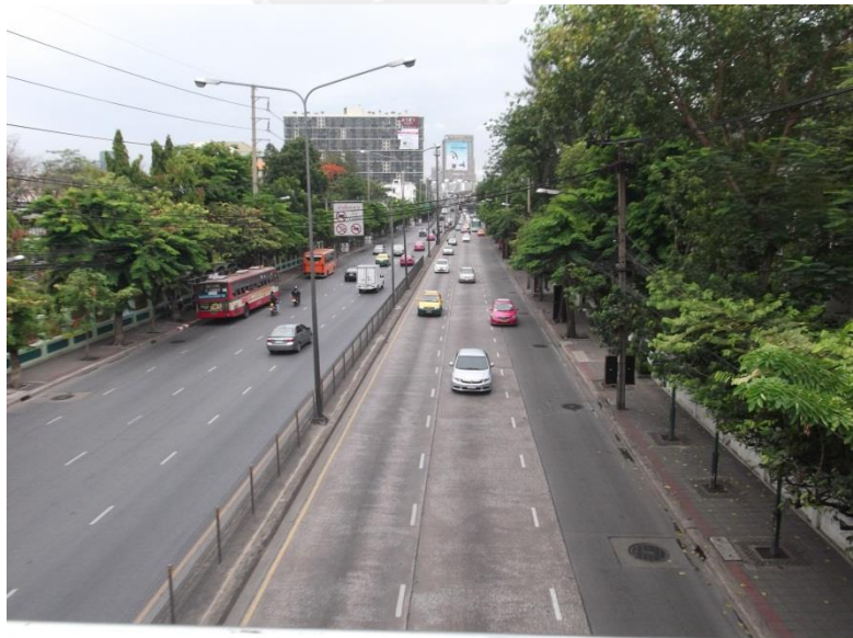
ภาพที่ ง-2 ลักษณะโครงสร้างถนนดินแดง
