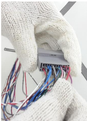
6 เสียบสายไฟจนครบทุกเส้น
