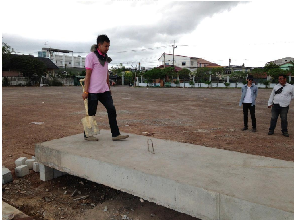
ภาพที่ 4.29 ตรวจสอบความเรียบร้อย หลังจากแผ่นพื้นถูกวางเรียบร้อย
