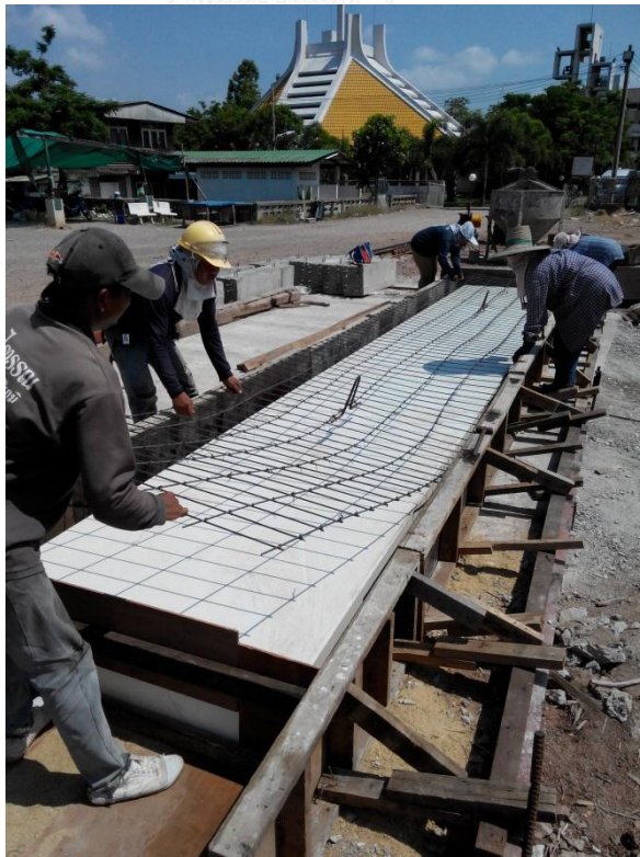
ภาพที่ 4.17 หลังจากผูกเหล็กเรียบร้อย นำมาวางบนแผ่นโฟม Eps
