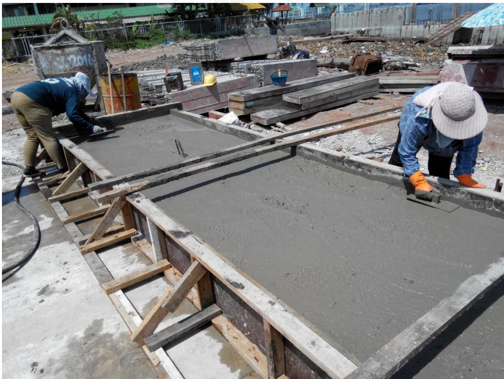
ภาพที่ 4.21 ใช้เกรียงไม้ เก็บผิวหน้าพื้นคอนกรีต เพื่อความเรียบร้อยและสวยงาม
