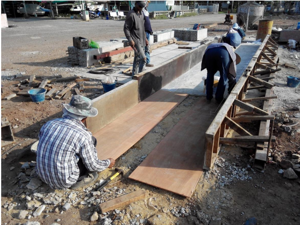
ภาพที่ 4.12 เข้าแบบพื้นพร้อมค้ำยันแผ่นพื้น
