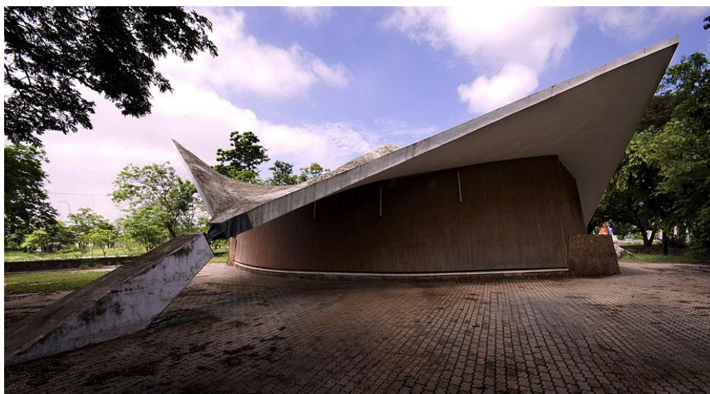
ภาพที่ 2.62 บริเวณภายนอกของคูลูร์สมนาคาร์ ซึ่งเป็นโครงสร้างเปลือกแข็งบาง
