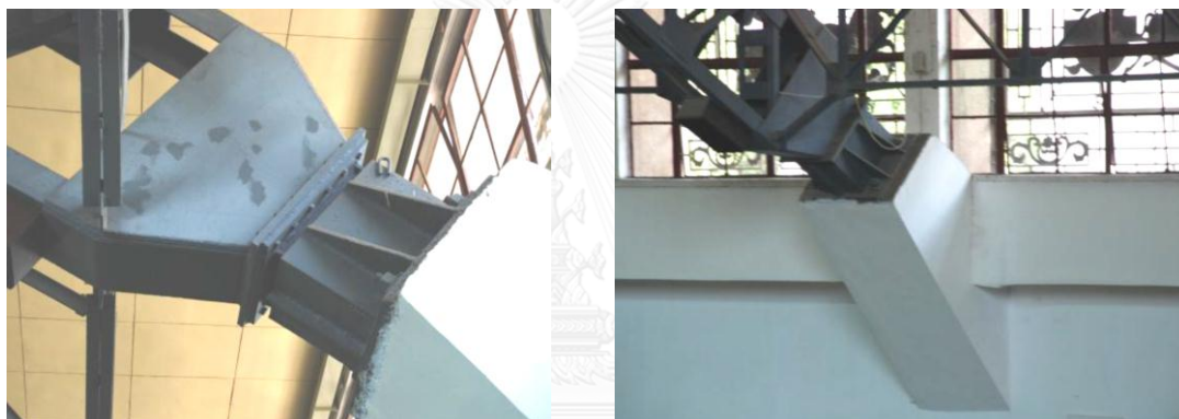
ภาพที่ 2.9 แสดงฐานรองรับแบบยึดแน่น (Fixed Supports) [3]
