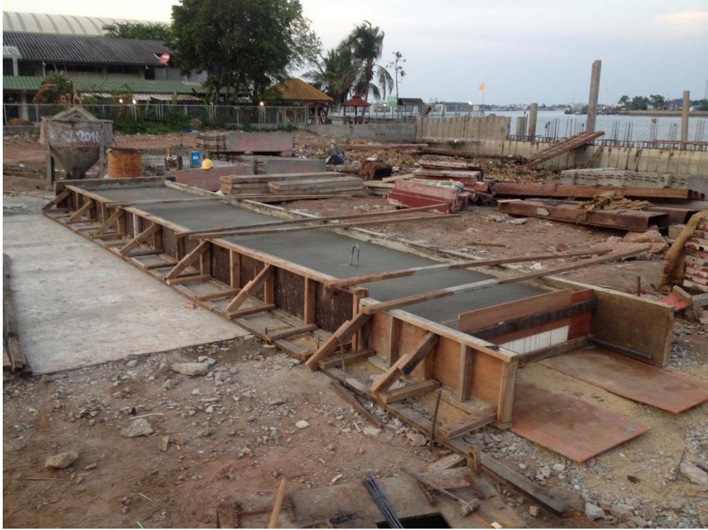
ภาพที่ 4.22 ขั้นตอนการเทคอนกรีตสำเร็จรูป เสร็จเรียบร้อย
