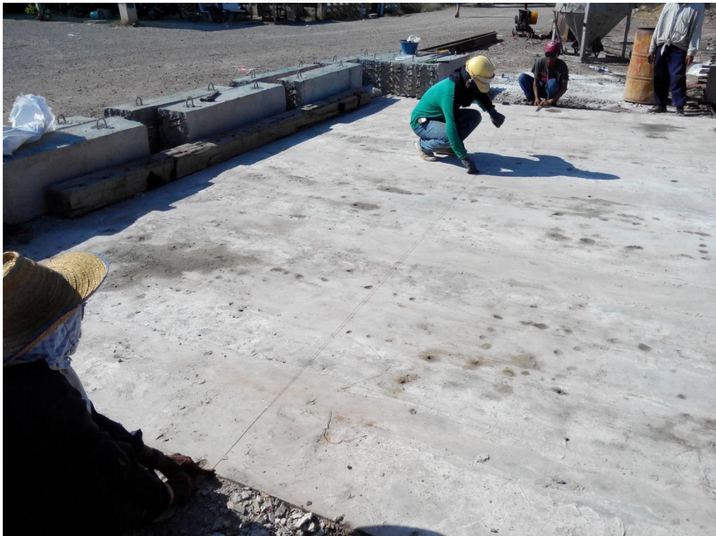
ภาพที่ 4.11 วางผัง กำหนดจุดวางแผ่นพื้นโพลีเม Eps หนา 10 นิ้ว ยาว 8.00 ม.
