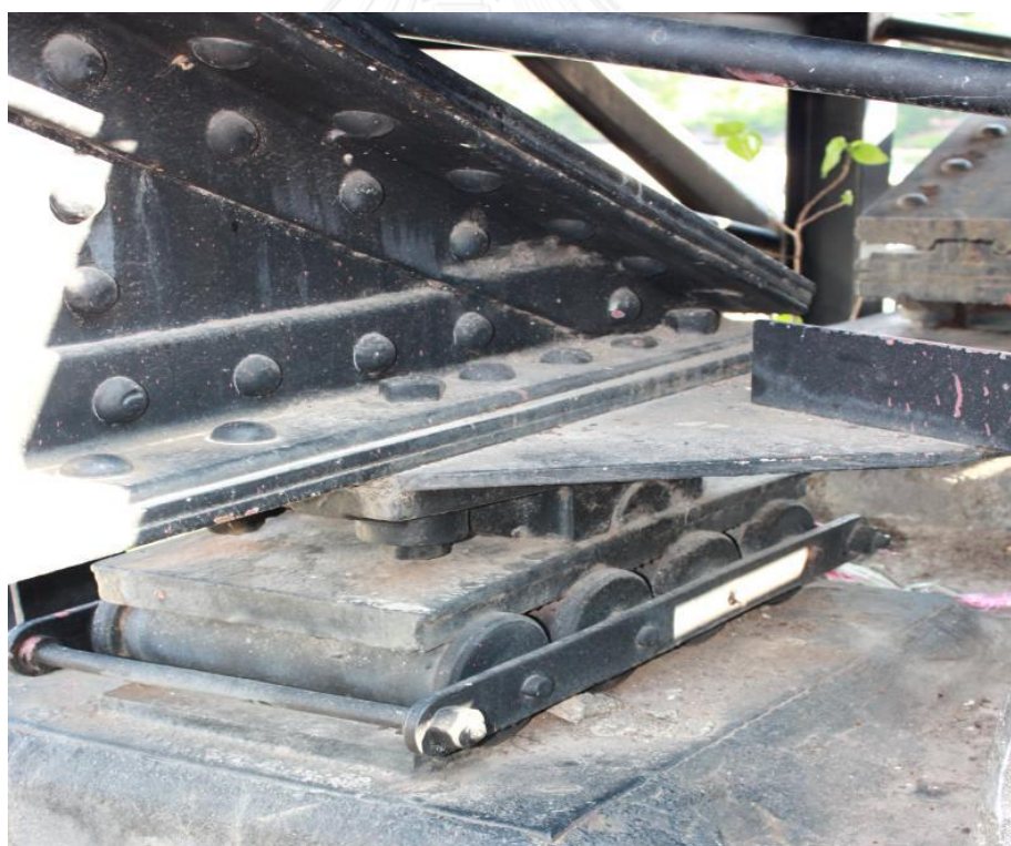
ภาพที่ 2.5 แสดงฐานรองรับแบบยึดหมุนเคลื่อนที่ได้(Roller Supports) [3]
