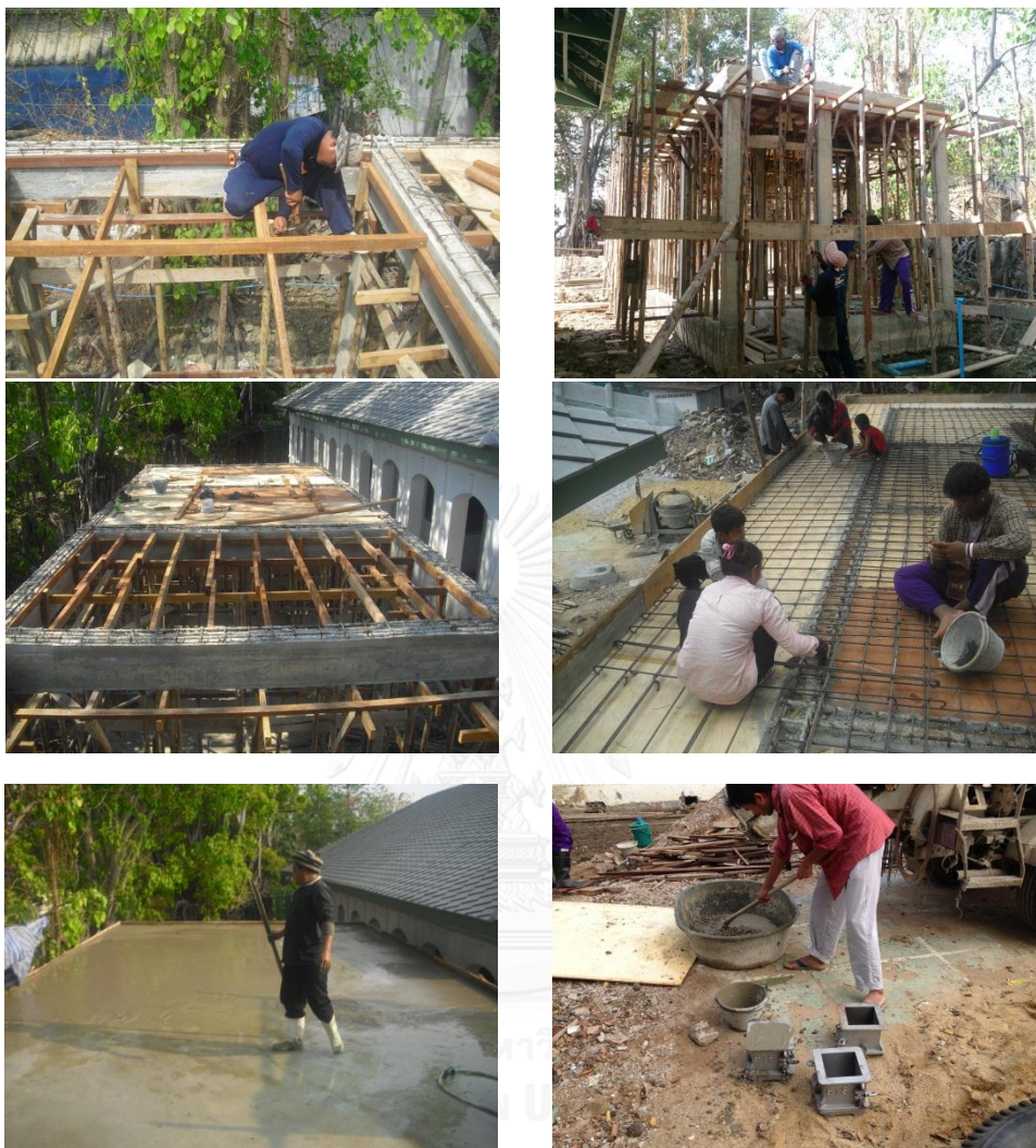
ภาพที่ 2.53 การก่อสร้างพื้นหล่อในที่
