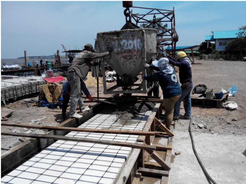
ภาพที่ 4.19 เริ่มขั้นตอนการเทคอนกรีต
