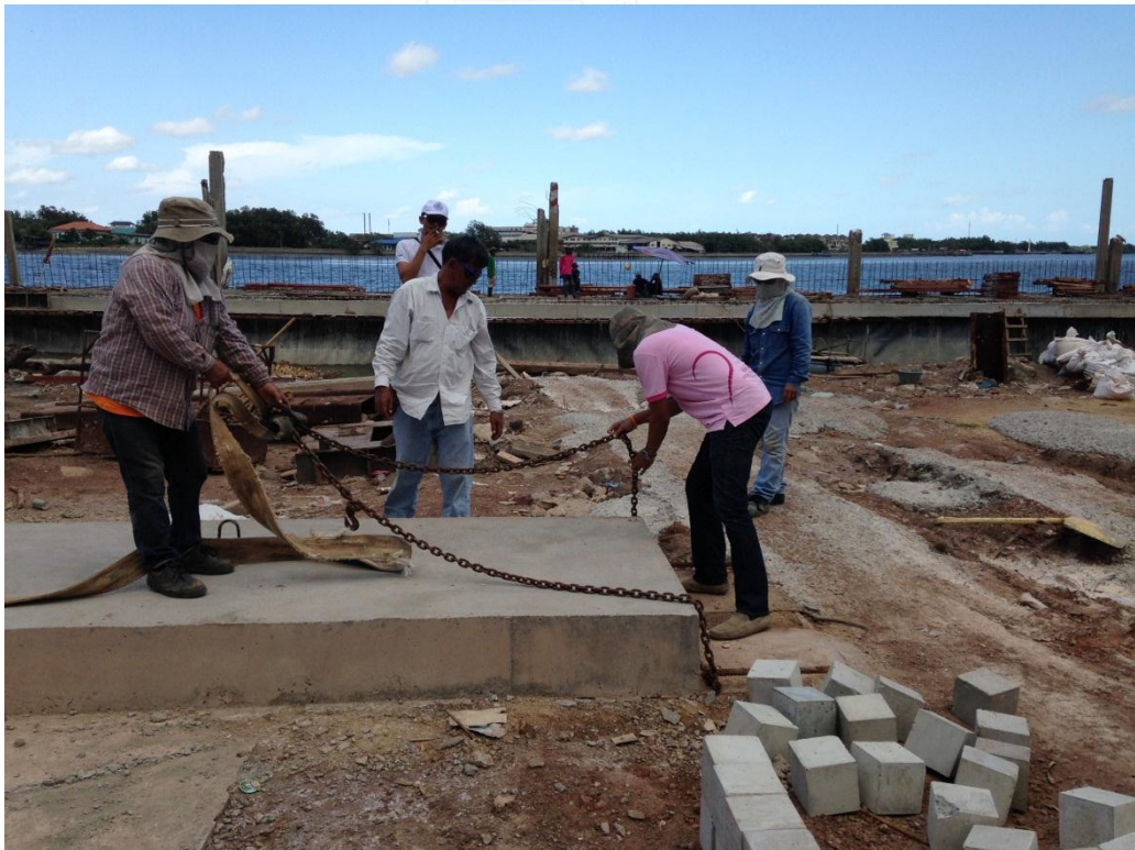
ภาพที่ 4.25 แผ่นพื้นพร้อมที่จะถูกยกวางบน Support ที่เตรียมไว้
