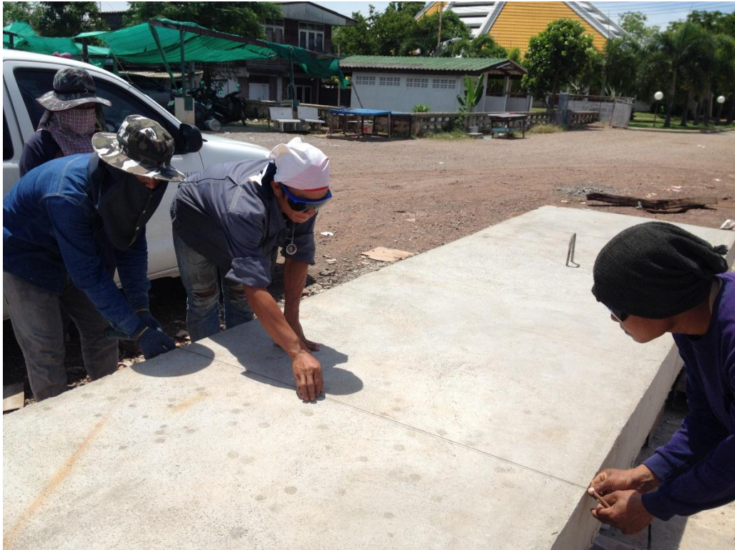
ภาพที่ 4.35 หลังจากได้ระยะทุกๆ 1.00 ม. ก็ทำการตีเส้นแบ่งเป็น 8 ส่วน
