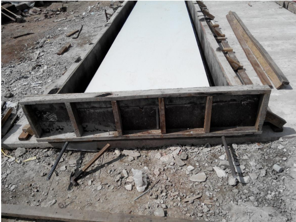
ภาพที่ 4.16 ตีแบบปิดหัว-ท้าย พร้อมวางเหล็ก DB25 จำนวน 2 เส้น
