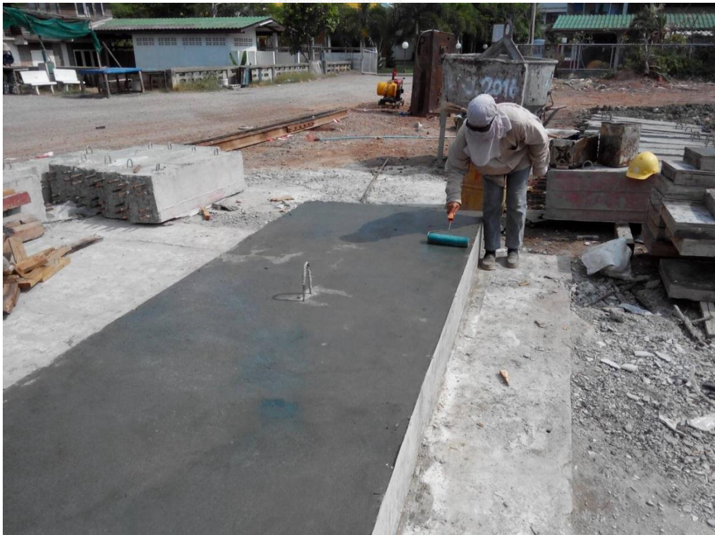
ภาพที่ 4.23 หลังจากทิ้งให้แผ่นพื้นแข็งตัว ก็ทำการแกะแบบพร้อมทาน้ำยาบ่มคอนกรีต
