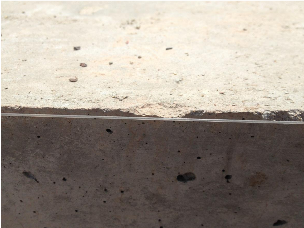
ภาพที่ 4.33 ชิ่งเส้นเอ็น เพื่อตรวจสอบการแอมตัวของแผ่นพื้น
