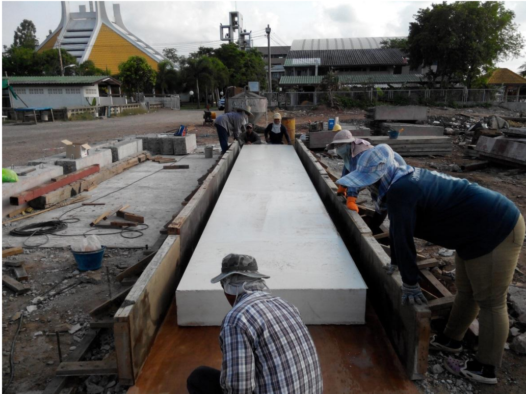
ภาพที่ 4.14 วางแผ่นโฟม Eps เข้าในแบบ เรียบร้อย
