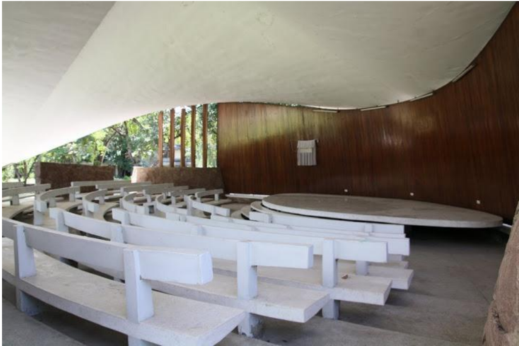
ภาพที่ 2.63 บริเวณภายในของครุส์มมนาการ ซึ่งเป็นโครงสร้างเปลือกแข็งบาง
