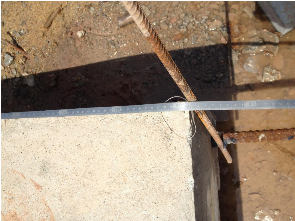
ภาพที่ 4.36 ตรวจสอบความยาวของแผ่นพื้น เท่ากับ 8.00 ม.
