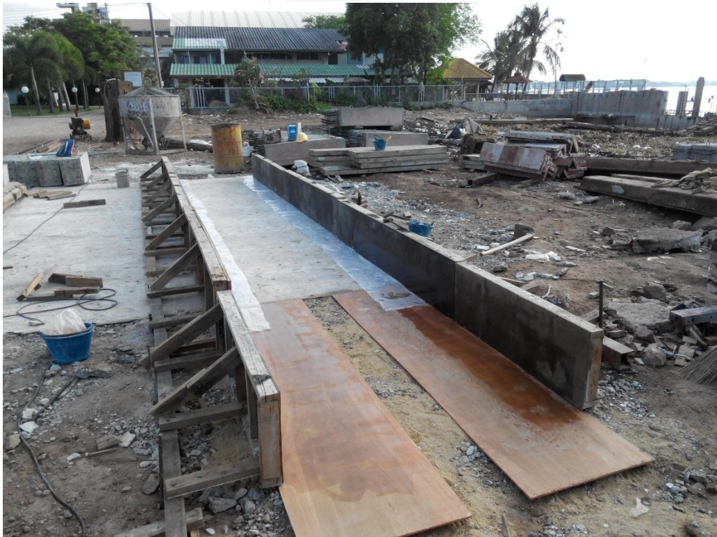
ภาพที่ 4.13 ปูแผ่นพลาสติกรองแผ่นพื้นและทาน้ำมัน เสร็จเรียบร้อย
