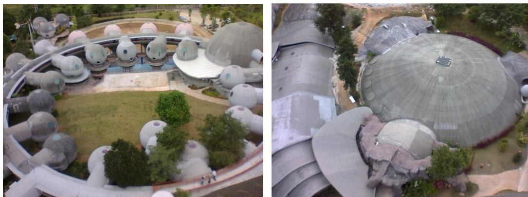
ภาพที่ 2.60 บริเวณภายนอกของอาคารโดมโครงสร้างเปลือกบางด้วยโพน
