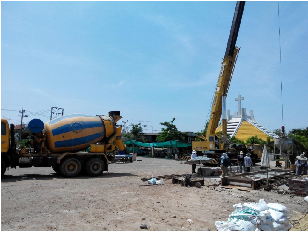
ภาพที่ 4.18 รถปูนและรถเครนยกกะบะคอนกรีตสำเร็จ พร้อมหน้างาน
