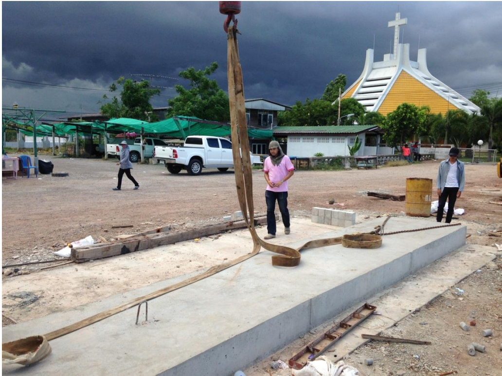
ภาพที่ 4.24 ตรวจสอบแผ่นพื้นหลังจากอายุครบ 28 วัน
