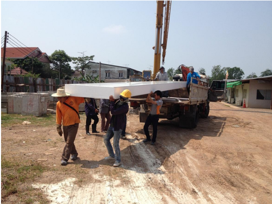
ภาพที่ 4.8 ขั้นตอนการขนย้ายแผ่นโฟม Eps หนา 10 นิ้ว ยาว 8.00 ม. ลงหน้างานทดสอบ
