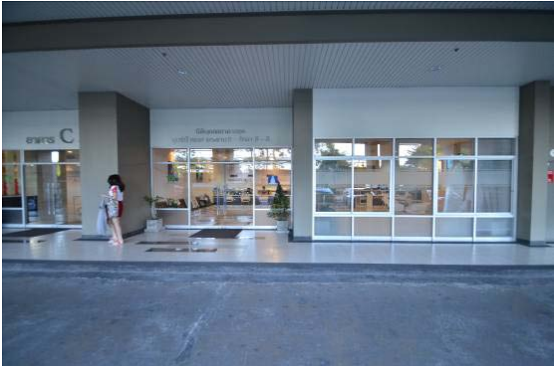
รูปที่ 4.51 แสดงสำนักงานนิติบุคคล และ Lobby อาคาร C
