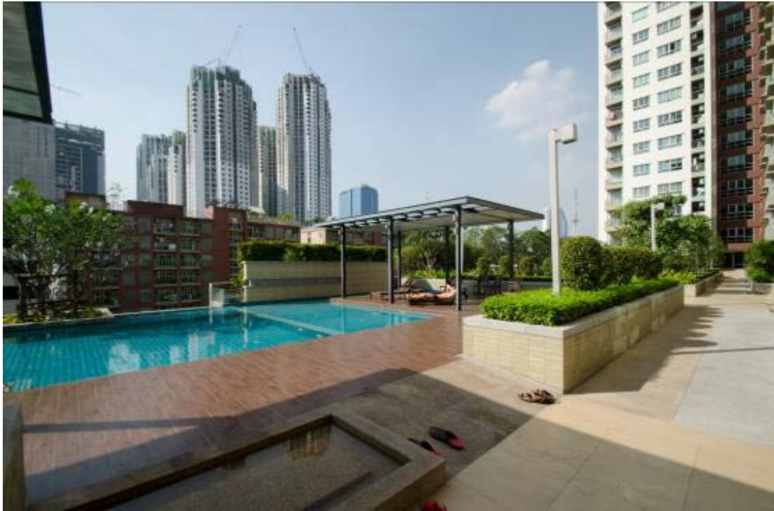
รูปที่ 4.61 แสดงสระว่ายน้ำ ที่ชั้น 5
