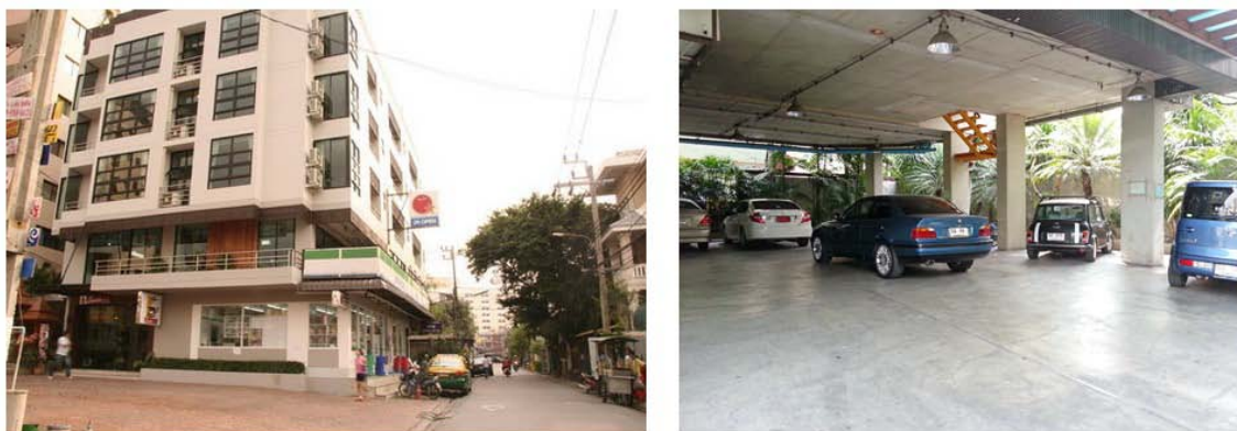
ภาพที่ 4.7 ภาพที่จอดรถ และบรรยากาศด้านหน้าอาคารฟอร์จูนี 1
