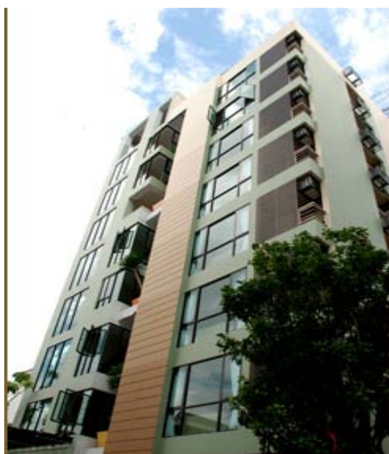
ภาพที่ 1.3 ภาพอพาร์ทเมนต์ที่จะทำการศึกษา คือ อาคารฟอร์ยู
