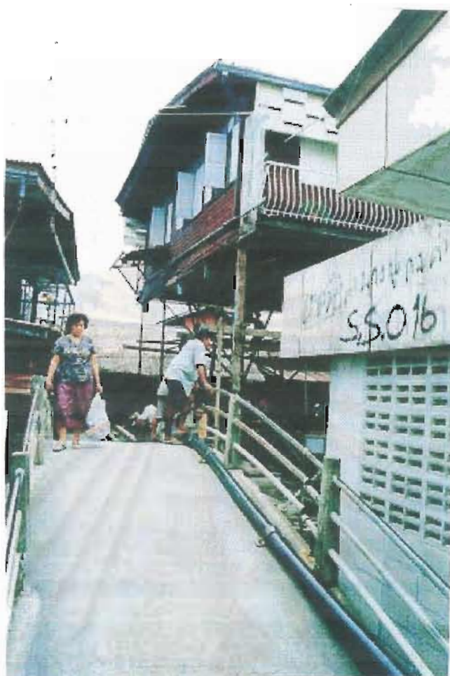
ภาพที่ 21 แสดงสะพานข้ามคลองย่อยในชุมชน จะสังเกตเห็นท่ออย่างแข็งสีดำซึ่งขนานไปกับสะพาน ซึ่งใช้ส่งน้ำใช้อุปโภค-บริโภค
