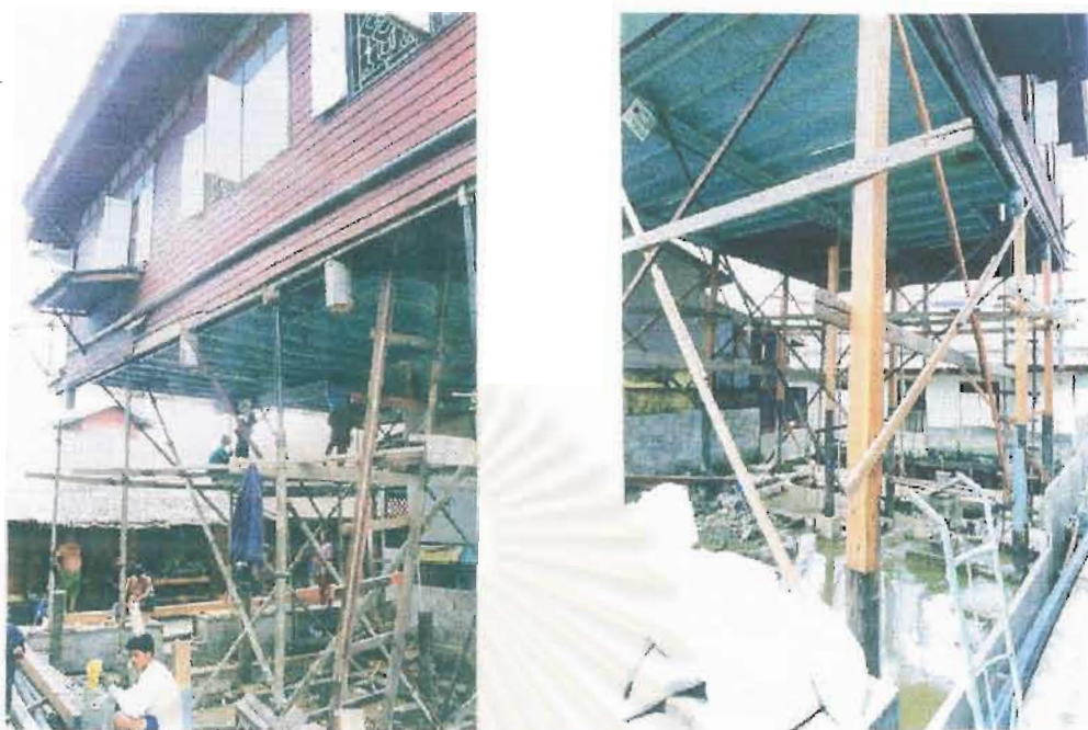
ภาพที่ 4-5 เป็นรูปที่แสดงการติดบ้าน โดยการทำฐานรากใหม่และต่อเพิ่มความสูงของเสา
