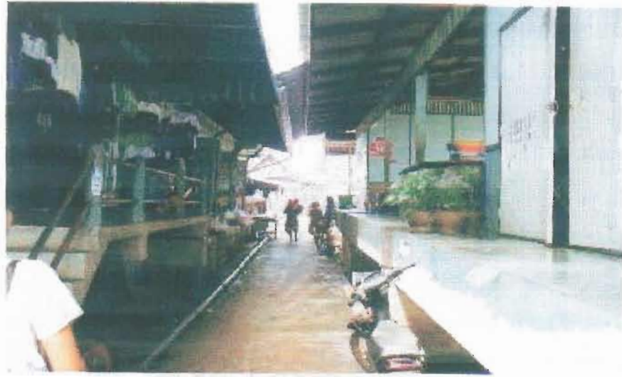
ภาพที่14 ภาพแสดงทางเดินเท้าภายในชุมชนซึ่งเป็นส่วนที่ชุมชนหนาแน่น มีบ้านเรือน ขนานไปทั้งสองข้างทางเดิน
