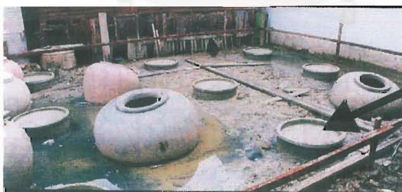
ภาพที่ 3 แสดงตอม่อฐานรากเพื่อสร้างบ้านใหม่โดยใช้ถ้งส้วม
