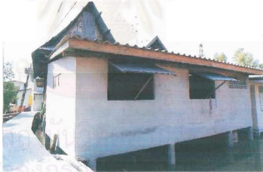
ภาพที่ 10 ภาพบ้านเรือนไทยซึ่งปรับปรุงฐานราก และเพิ่มเติมพื้นที่ใช้สอยรอบบริเวณบ้านเรียบร้อยแล้ว
