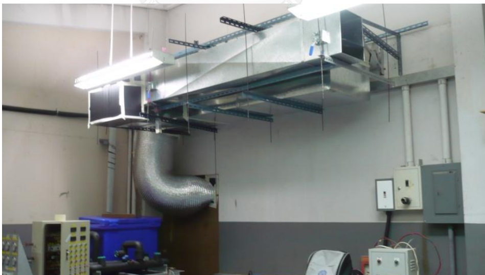
รูปที่ 5.1 ท่อลมที่ได้ทำการติดตั้งเพื่อควบคุมลมเข้า-ออกเครื่องเป่าลมเย็น
