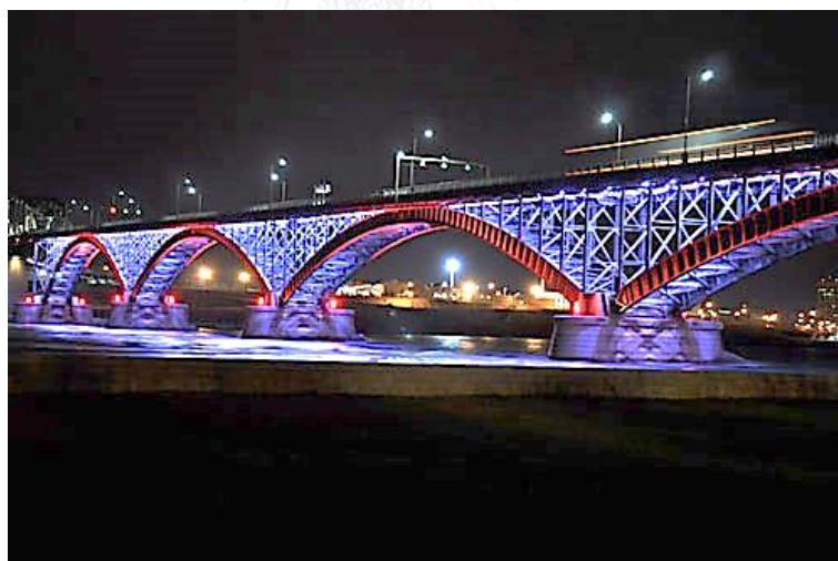
ภาพที่ 6-9 ตัวอย่างการติดตั้งไฟส่องสว่างบริเวณสะพาน
