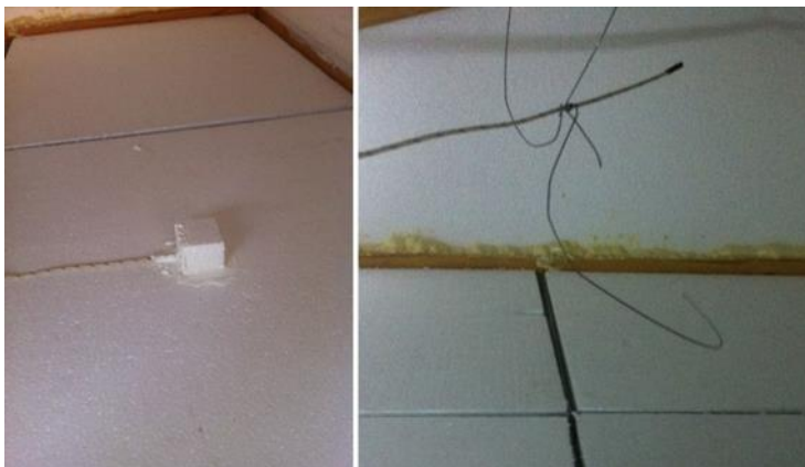
ภาพที่ 3-15 ตัวอย่างการติดตั้งหัววัดอุณหภูมิที่ผิววัสดุ (ซ้าย) และตัวอย่างการติดตั้งหัววัดอุณหภูมิอากาศ (ขวา)
