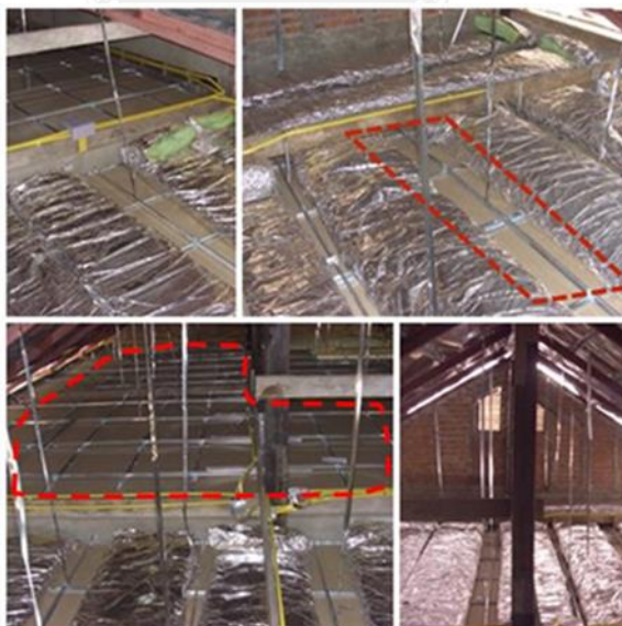
ภาพที่ 1-2 ตัวอย่างฉนวนกันความร้อนใยแก้วชนิดปูเนื้อฝ้าเพดาน [2]
