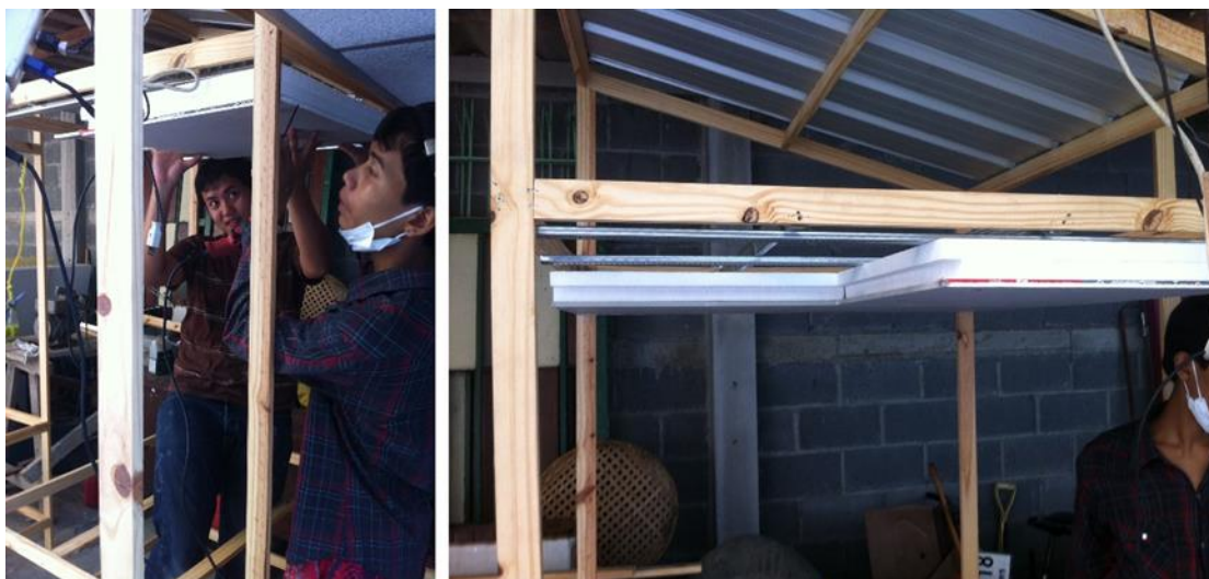
ภาพที่ 3-10 การติดตั้งแผ่นฝ้าเพดานฉนวนกันความร้อนที่แก้ไขการรั่วซึมของความร้อนบริเวณรอยต่อระหว่างแผ่นฝ้าเพดานกับโครงฝ้าเพดานเหล็กชุบสังกะสีที่ติดตั้งที่โมเดลจำลอง
