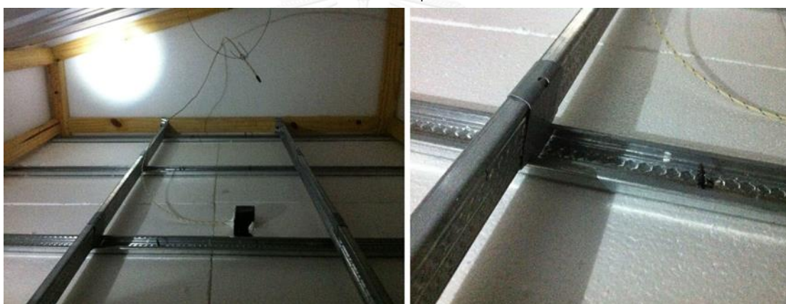
ภาพที่ 3-11 ระบบฝ้าเพดานฉนวนกันความร้อนที่แก้ไขการรั่วซึมของความร้อนบริเวณรอยต่อระหว่างแผ่นฝ้าที่ติดตั้งแล้วเสร็จ (ซ้าย) และการยึดแผ่นฝ้าเพดานฉนวนกันความร้อนกับโครงเหล็กชุบสังกะสีด้วยสกรุดำยาว 3 นิ้ว (ขวา)
