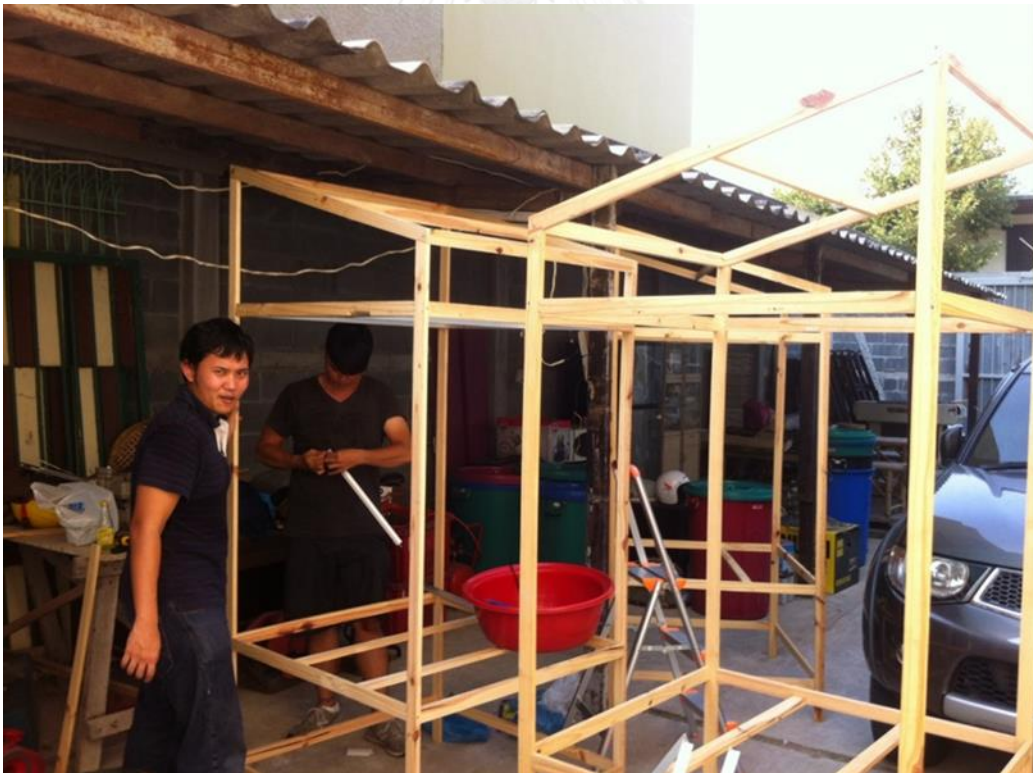
ภาพที่ 3-21 การติดตั้งโครงโมเดลจำลองสำหรับทดลอง
