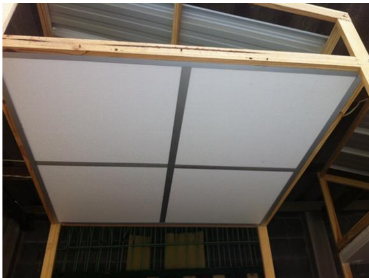
ภาพที่ 3-34 ฝ้าเพดานระบบ T-bar ด้วยแผ่นฝ้าเพดานฉนวนกันความร้อนในท้องตลาด EPS foam ความหนาแน่น 1.25 ปอนด์ต่อลูกบาศก์ฟุต ความหนา 1 นิ้ว ขนาดแผ่น 60 เซนติเมตร x 60 เซนติเมตร
