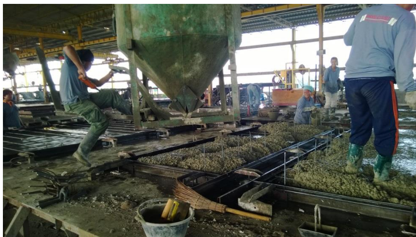
ภาพที่ 4.4 การเทคอนกรีตขึ้นส่วนผนังคอนกรีตสำเร็จรูป
