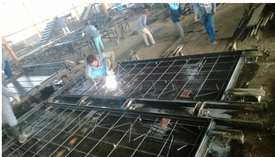
ภาพที่ 4.3 การวางเหล็กเสริมขึ้นส่วนผนังคอนกรีตสำเร็จรูป
