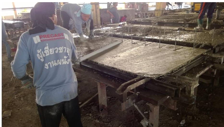
ภาพที่ 4.5 การขัดผิวหน้าขึ้นส่วนผนังคอนกรีตสำเร็จรูป
