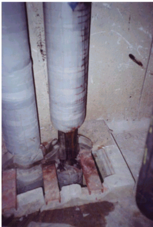
รูปภาพที่ 3.14 ท่อทางตั้งในห้องmixed air chamber สามารถทะลุถึงกันทุกชั้น ทำให้อากาศที่ร้อนและชื้นกว่าผสมกับอากาศที่กลับเข้ามา กลายเป็นลมจ่ายที่มีอุณหภูมิและความชื้นสูง
