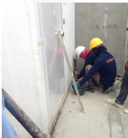
รูปที่ 5.7 การติดตั้งห้องน้ำสำเร็จรูป โดยการตรวจสอบตำแหน่งระยะ ระดับให้ถูกต้องก่อนติดตั้ง
