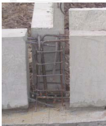
รูปที่ 2.16 การใส่เหล็กเสริมระหว่างปลายคาน (ภาณุรัตน์ โพธิ์งาม, 2548)
