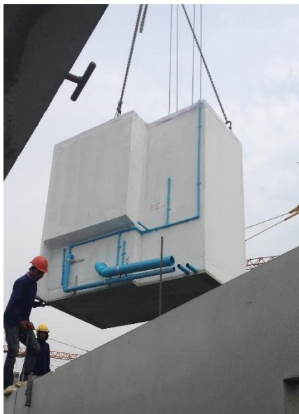
รูปที่ 5.6 การติดตั้งห้องน้ำสำเร็จรูปที่ใช้จำนวนแรงงานฝีมือน้อยลง
