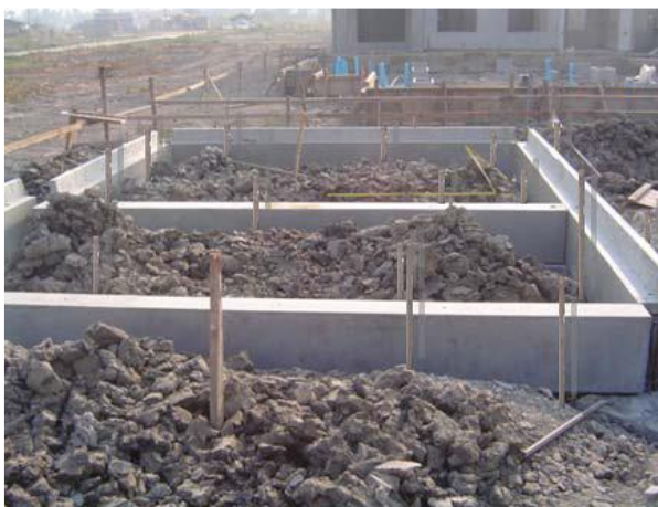
รูปที่ 2.15 การวางคานสำเร็จรูป (ภาณุรัตน์ โพธิ์งาม, 2548)
