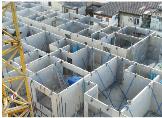
รูปที่ 4.10 การติดตั้งผนังชั้น 3
