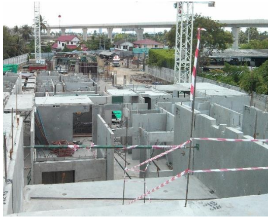
รูปที่ 4.9 การติดตั้งพื้นชั้น 3
