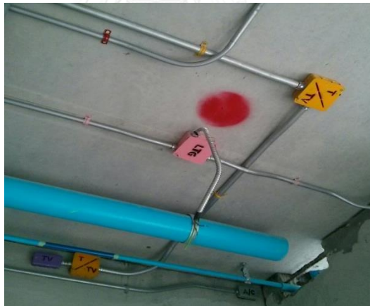
รูปที่ 4.6 การติดตั้งงานระบบ
