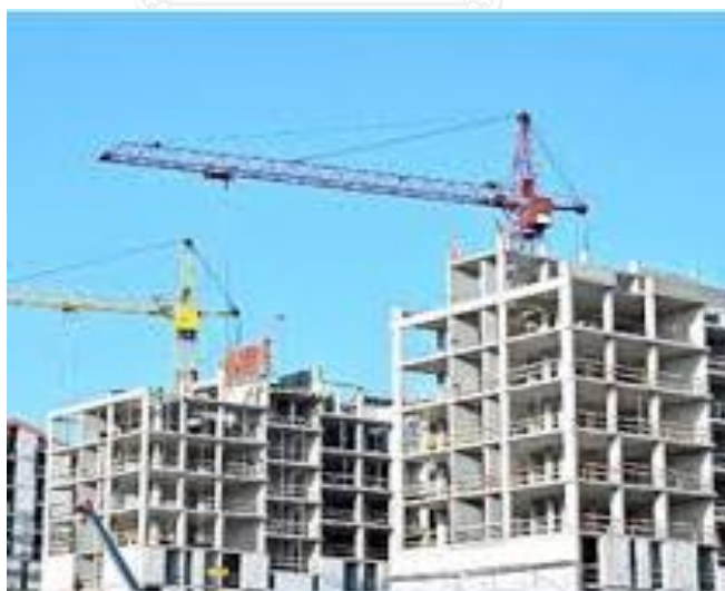
รูปที่ 2.2 โครงสร้างระบบเสาและแผ่นพื้น (ที่มา : www.bloggang.com )
