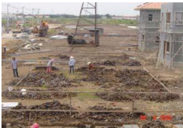
รูปที่ 2.13 การเตรียมงานฐานราก (ภาณุรัตน์ โพธิ์งาม, 2548)
