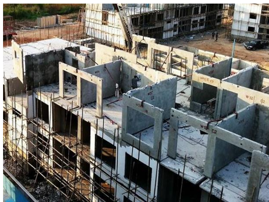
รูปที่ 4.11 การติดตั้งผนังชั้น 4
