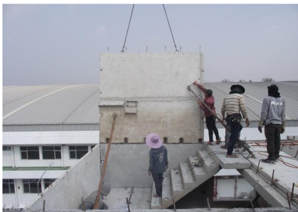
รูปที่ 2.20 การติดตั้งแผ่นผนังสำเร็จรูป (สีบตระกูล สมบัติทิพย์, 2554)
