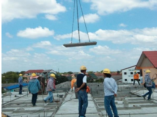
รูปที่ 4.5 การติดตั้งพื้นชั้น 2
