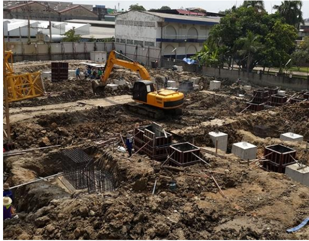
รูปที่ 4.1 การจัดทำฐานราก
