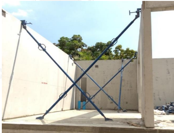
รูปที่ 4.4 การติดตั้งผนังชั้น 1
