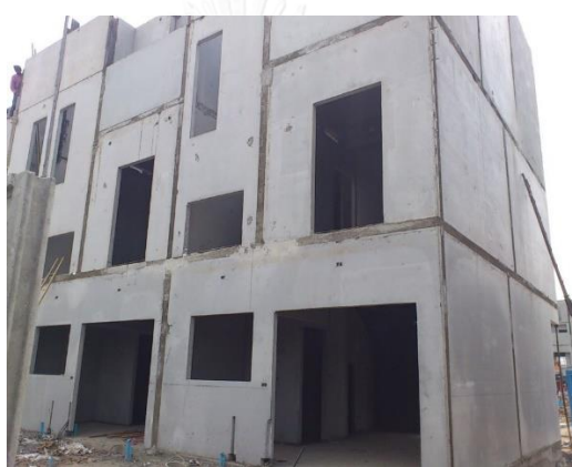
รูปที่ 2.3 โครงสร้างระบบผนังรับน้ำหนัก (ที่มา : www.nrv.co.th )
