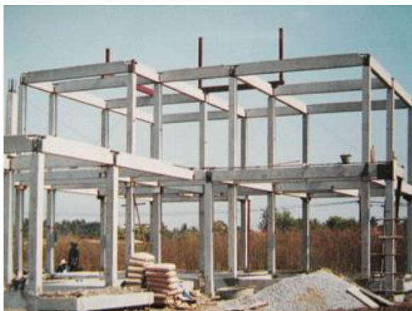
รูปที่ 2.1 โครงสร้างระบบเสาและคาน (ที่มา : http://www.nrv.co.th )
