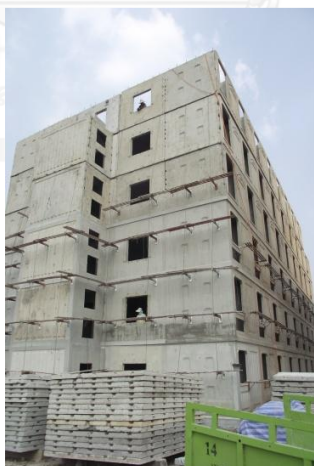
รูปที่ 2.23 โครงการก่อสร้างอาคารหอพัก 8 ชั้นด้วยระบบสำเร็จรูป (สีปตรากุล สมบัติทิพย์, 2554)
