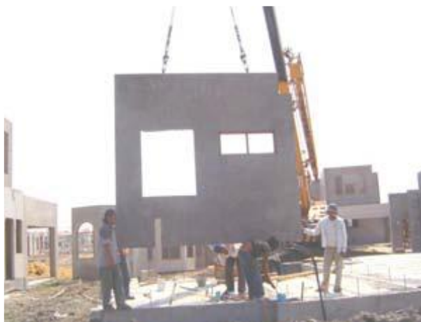
รูปที่ 2.17 การยกติดตั้งผนังสำเร็จรูปชั้นล่าง (ภาณุรัตน์ โพธิ์งาม, 2548)
