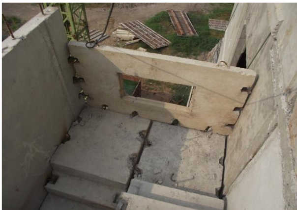
รูปที่ 2.22 รอยต่อระหว่างผนังและบันได (สีปตรากุล สมบัติทิพย์, 2554)
