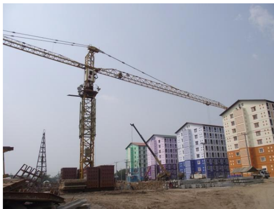
รูปที่ 2.24 เครื่องจักรที่ใช้ในโครงการอาคารหอพัก 8 ชั้น (สีบตระกูล สมบัติทิพย์, 2554)
