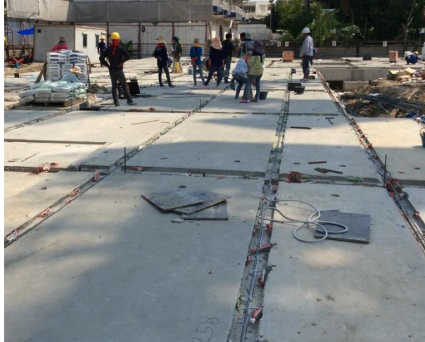
รูปที่ 4.3 การติดตั้งพื้นชั้น 1
