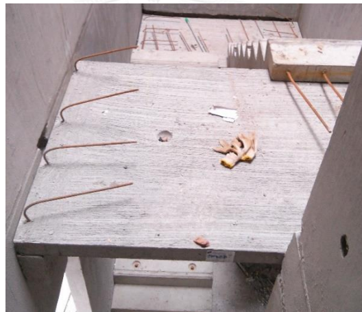
รูปที่ 4.8 การติดตั้งขานพักบันได
