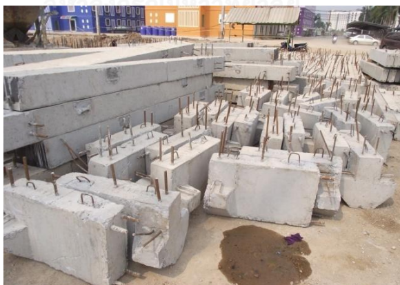
รูปที่ 2.25 การจัดเก็บชิ้นส่วนสำเร็จรูปภายในโครงการ (สีบตระกูล สมบัติทิพย์, 2554)
