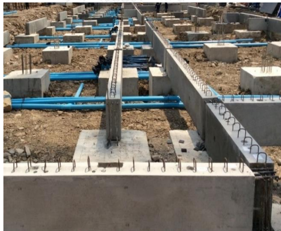
รูปที่ 4.2 การติดตั้งคานคอดินและระบบสาธารณูปโภคกลางพื้นที่ชั้น 1
