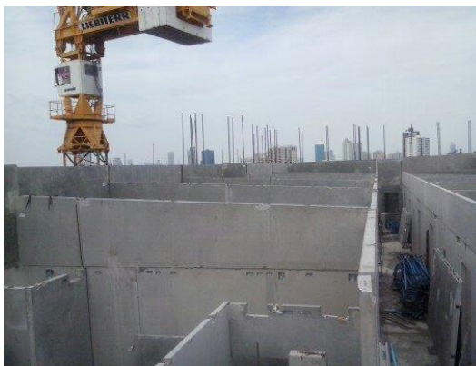
รูปที่ 4.12 การติดตั้งผนัง Roof Tank
