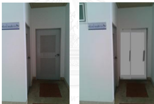
ภาพที่ 91 เปลี่ยนเป็นประตูบานเลื่อนเพื่อสะดวกแก่ผู้สูงอายุมากขึ้น
