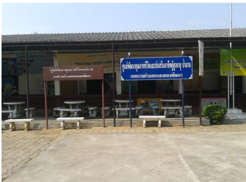
ภาพที่ 19 ศูนย์อเนกประสงค์สำหรับผู้สูงอายุหนองตอง จังหวัดเชียงใหม่
