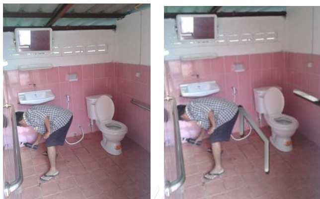
ภาพที่ 90 เพิ่มราวจับป้องกันอันตรายที่อาจเกิดขึ้นในห้องน้ำ
