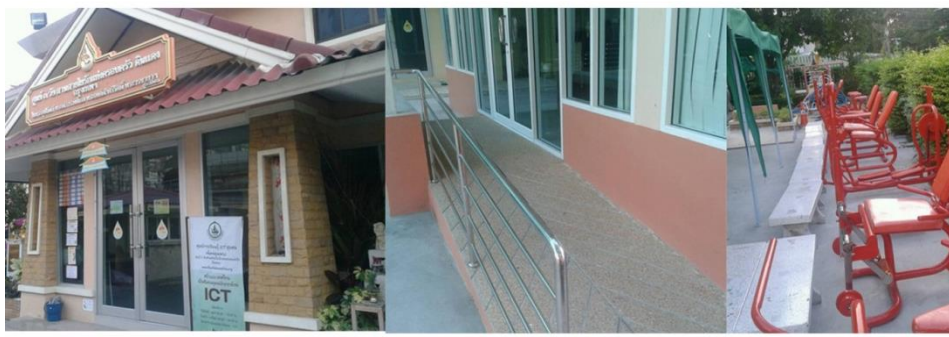
ภาพที่ 53 บรรยากาศภายนอกอาคาร ภาพที่ 54 ทางลาด ภาพที่ 55 เครื่องออกกำลังกาย
