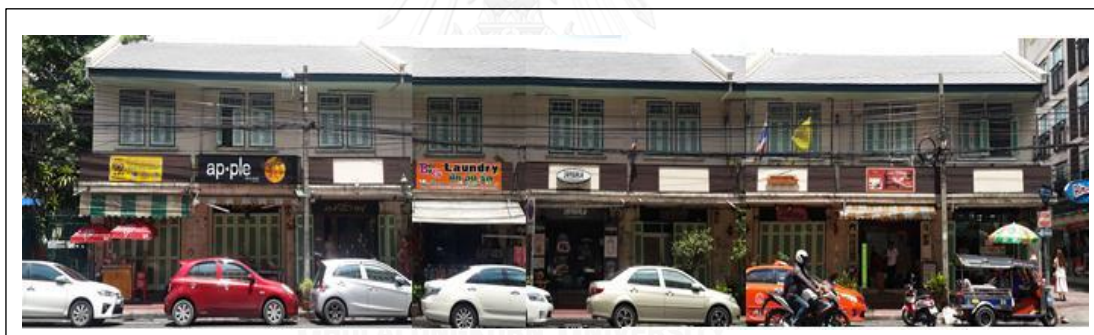
ภาพที่ 5.4 ลักษณะอาคารโครงการถนนพระอาทิตย์หลังการปรับปรุงซ่อมแซม
