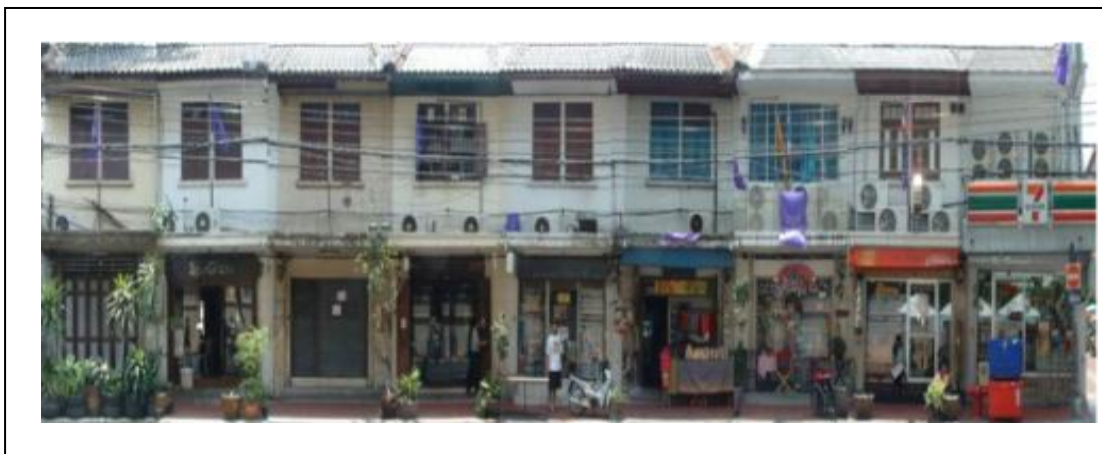
ภาพที่ 5.1 ลักษณะอาคารโครงการถนนพระอาทิตย์ก่อนการปรับปรุงซ่อมแซม
