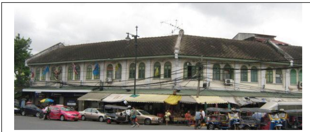
ภาพที่ 5.15 ลักษณะอาคารโครงการท่าเตียนก่อนปรับปรุงซ่อมแซม
