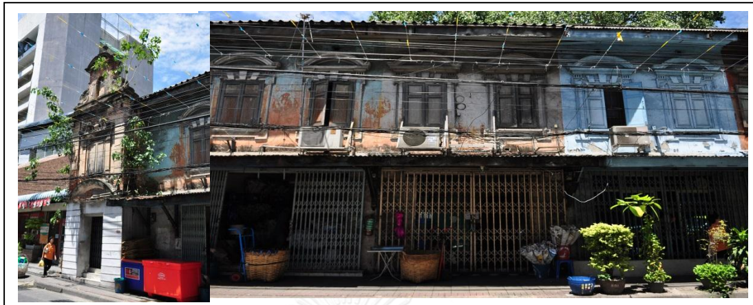
ภาพที่ 5.10 ลักษณะอาคารโครงการถนนบ้านหม้อก่อนปรับปรุงซ่อมแซม
