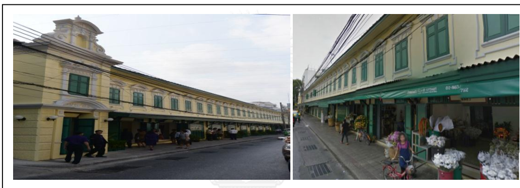
ภาพที่ 5.14 ลักษณะอาคารโครงการถนนบ้านหม้อหลังปรับปรุงซ่อมแซม
