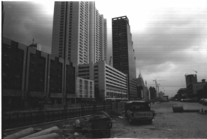
ภาพ 5. ถนนตัดใหม่ผ่านถนนสี่ลม และสุรวงศ์
