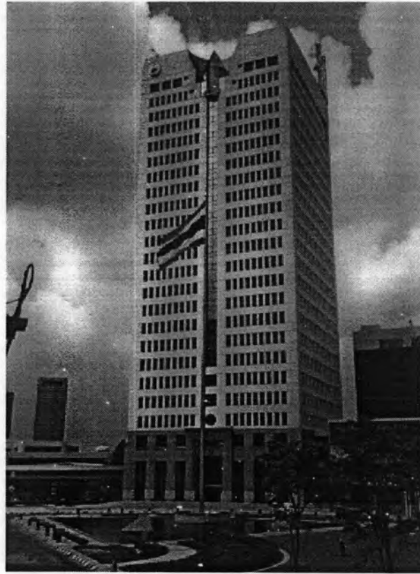
อาคารปตท. ส่วนอาคาร A
