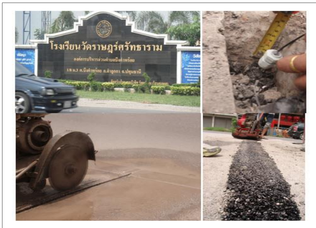
รูปที่ 3.2 การติดตั้งเครื่องมือวัดอุณหภูมิผิวทางและความชื้นของอากาศที่จังหวัดปทุมธานี
