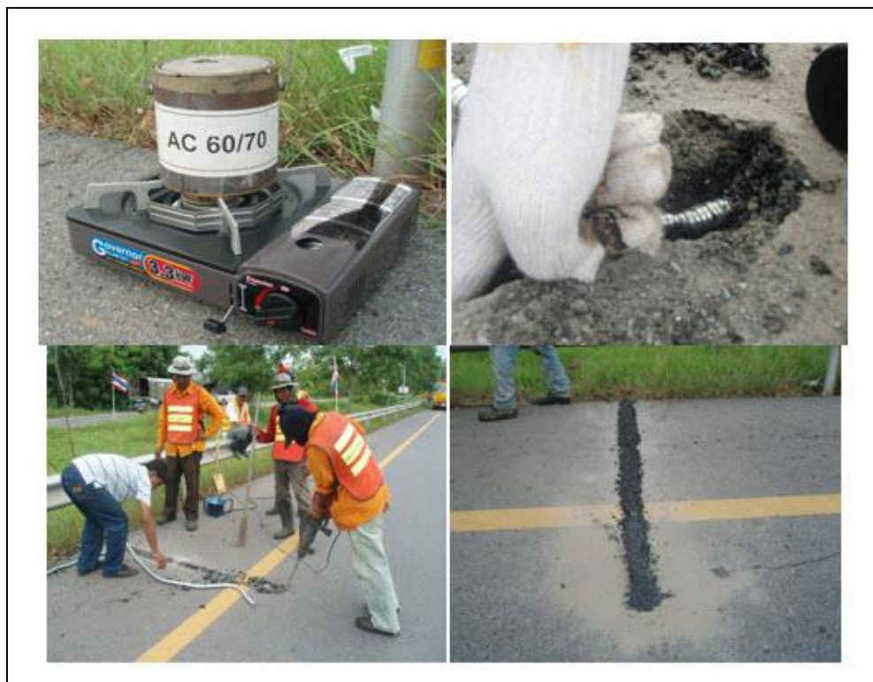
รูปที่ 3.4 การติดตั้งเครื่องมือวัดอุณหภูมิผิวทางและความชื้นของอากาศที่จังหวัดอ่างทอง
