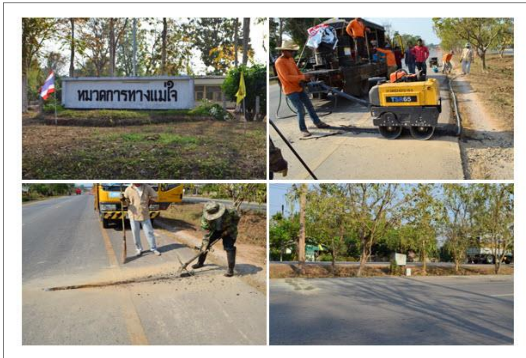
รูปที่ 3.1 การติดตั้งเครื่องมือวัดอุณหภูมิผิวทางและความชื้นของอากาศที่จังหวัดพะเยา
