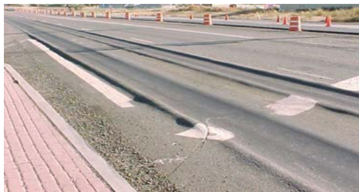
รูปที่ 2.5 การเกิดการทรุดตัวเป็นร่องล้อของแอสฟัลติกคอนกรีต (rutting)
