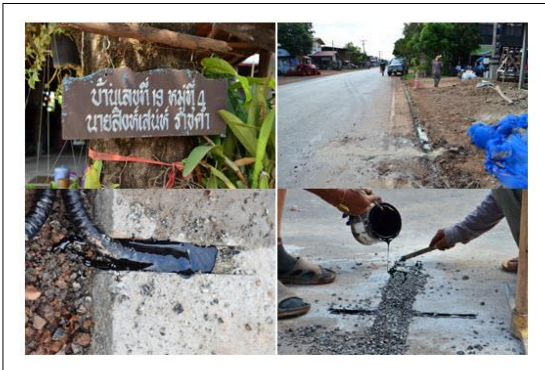
รูปที่ 3.3 การติดตั้งเครื่องมือวัดอุณหภูมิผิวทางและความชื้นของอากาศที่จังหวัดสกลนคร
