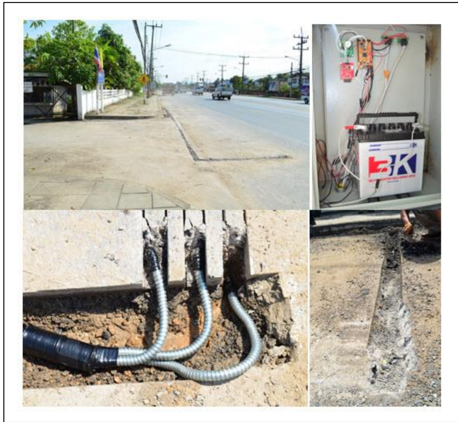
รูปที่ 3.5 การติดตั้งเครื่องมือวัดอุณหภูมิผิวทางและความชื้นของอากาศที่จังหวัดสงขลา
