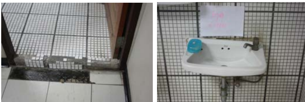
ภาพที่ 5.10 แสดงสภาพทรุดโทรมของห้องน้ำภายในอาคาร
