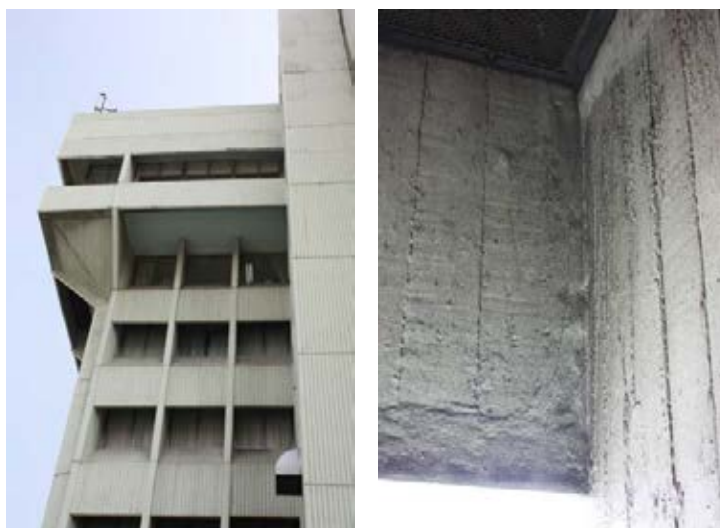
ภาพที่ 5.1 แสดงสภาพคราบสกปรกของผนังภายนอกอาคาร
