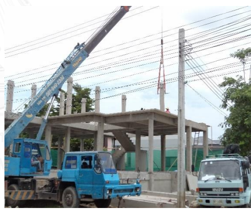
(ง) เครนยกเสาหล่อสำเร็จติดตั้งที่ชั้น 2
