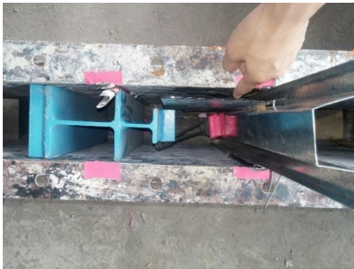
(ค) ติดตั้งแผ่นยางบิวไทล์ที่แบบหล่อเหล็กก่อนการเทคอนกรีตประเภทที่ 3
