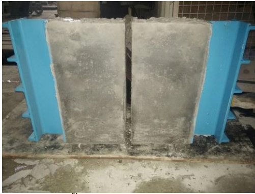
(ก) นำชิ้นส่วนคอนกรีตมายึดติดกัน
