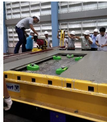
(ข) เทคอนกรีตผสมเสร็จ
