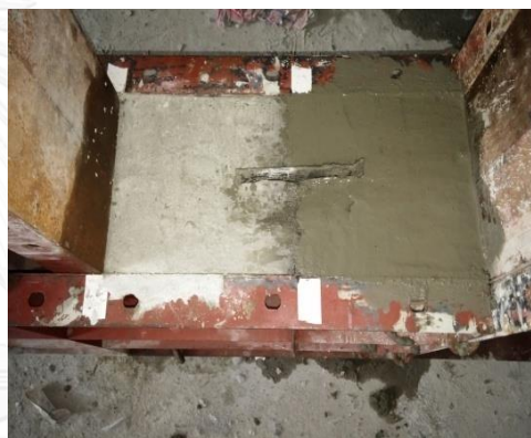
(ง) หลังจากเทคอนกรีตจนเต็มแบบหล่อ
