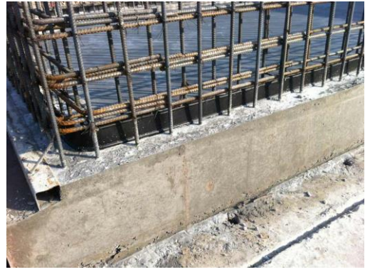
(ข) หลังจากทำความสะอาดแผ่นยาง PVC
