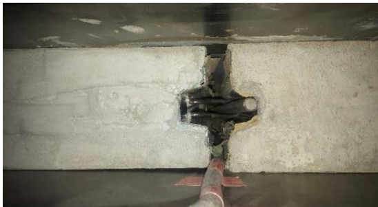
(ค) วางเหล็ก DB12 ผ่าน C-line ติดตั้งโฟมเส้นอุดร่อง และเทนอนชิ่งเกร้าท์
