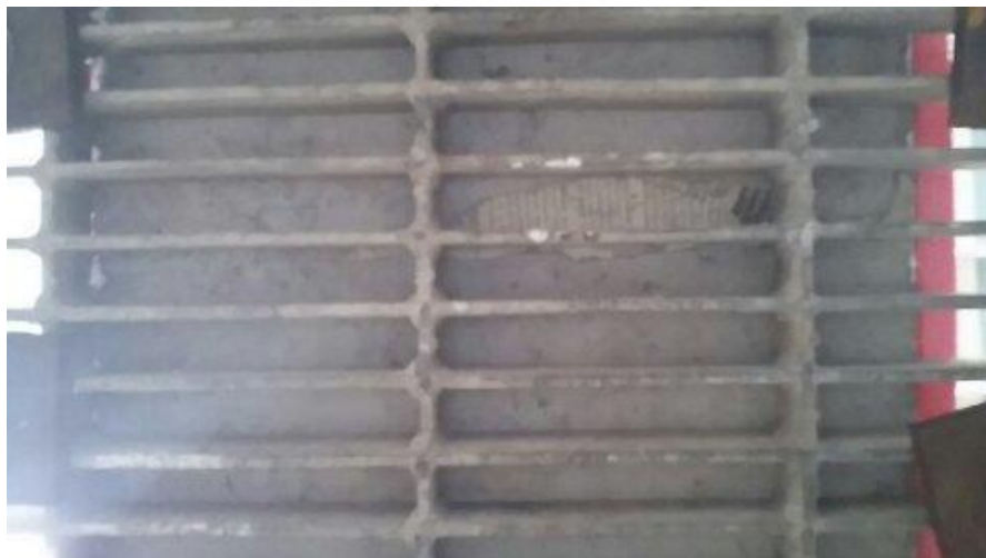
รูปที่ 4.3 ไม่พบน้ำซึมผ่านบริเวณด้านล่างของตัวอย่างที่ใช้แผ่นยางบิวไทล์ ในรอยต่อก่อสร้าง
