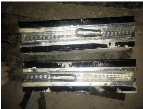
(ค) หลังจากคอนกรีตแข็งตัวแล้ว วางเหล็ก DB12 ผ่าน C-line และเทนอนซิ่งเกอร์ท์
