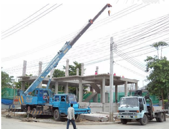
(ค) เครนยกชิ้นส่วนคอนกรีตหล่อสำเร็จ
