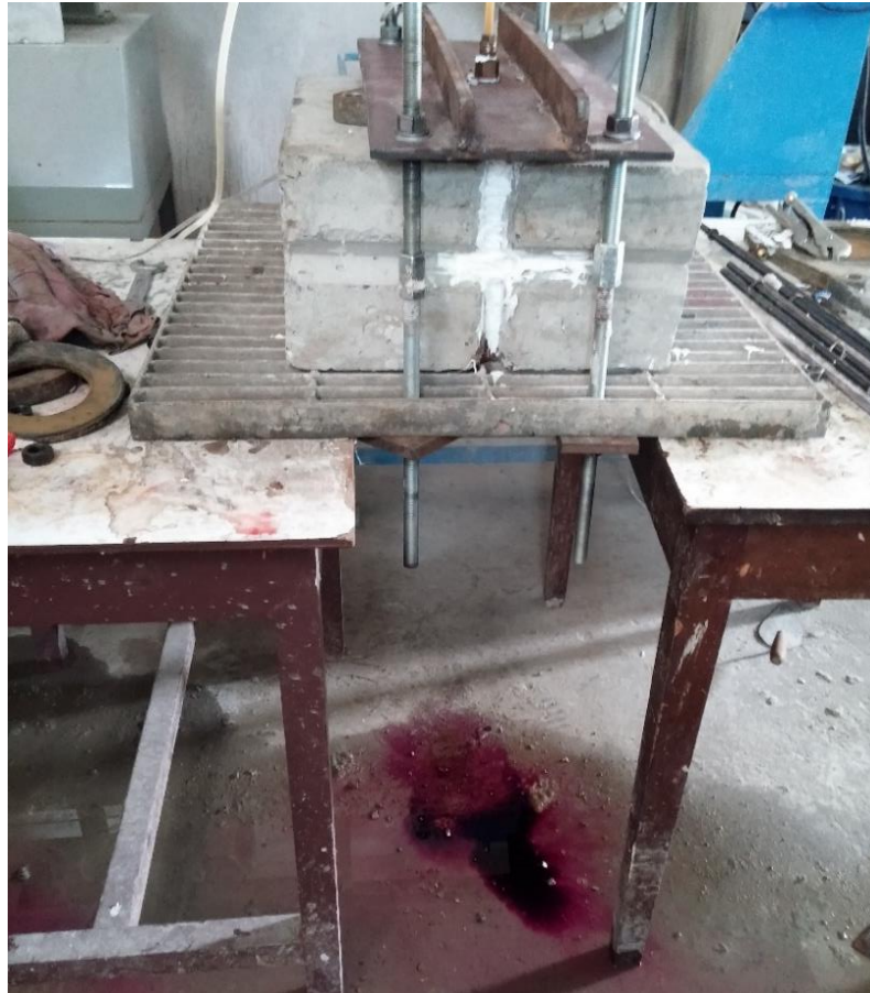
รูปที่ 4.2 พบน้ำรั่วซึมที่บริเวณด้านล่างของตัวอย่างที่ใช้แผ่นยางโพลีไวนิลคลอไรด์ ในรอยต่อ ก่อสร้าง
