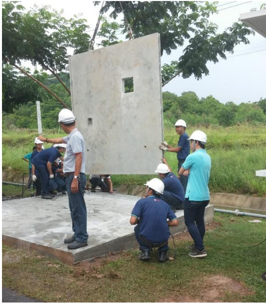
(ก) หลังจากคอนกรีตแข็งตัว ยกขนย้ายแผ่นคอนกรีตหล่อสำเร็จ
