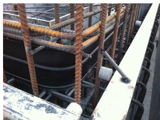
(ค) แผ่นยาง PVC ถูกผูกเข้ากับเหล็กเส้น ก่อนการเทคอนกรีตชั้นแรก
