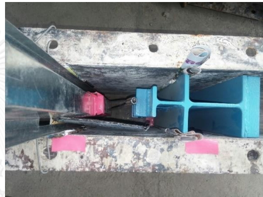
(ค) ติดตั้งแผ่นยางบิวไทล์ที่แบบหล่อเหล็กก่อนการเทคอนกรีตประเภทที่ 3
