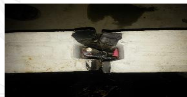
(ง) วาง DB12 ผ่าน Wire rope loop
