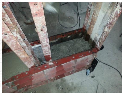
(ง) วางกระดาษที่รอยต่อ และเทคอนกรีตจนเต็มแบบหล่อ
