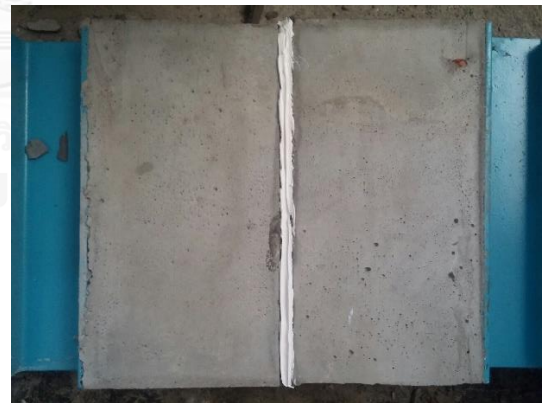
(จ) หลังจากนอนจริงเก่าที่แข็งตัวแล้ว ยิงวัสดุยาแนวกันน้ำซีมบนโคมเส้นลวดร่อนที่รอยต่อ
