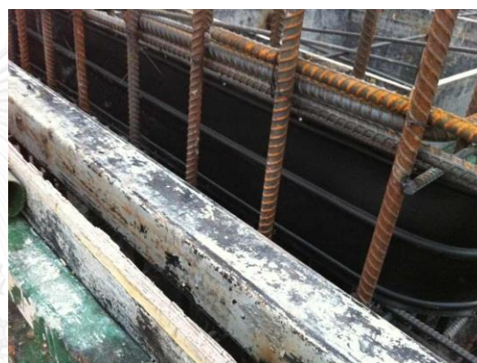
(ข) ทำการติดตั้งแผ่นยาง PVC ก่อนเทคอนกรีต
