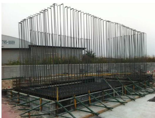
(ก) การก่อสร้างถึงเก็บน้ำเสีย
