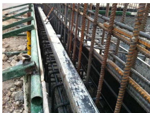
(ค) แผ่นยาง PVC ถูกผูกเข้ากับเหล็กเส้น ก่อนการเทคอนกรีตชั้นแรก
