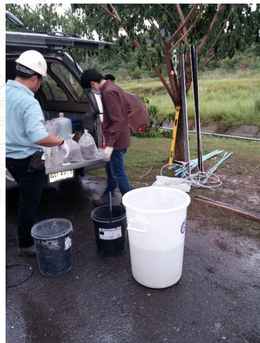
(ง) เตรียมติดตั้งวัสดุกันน้ำที่รอยต่อ
