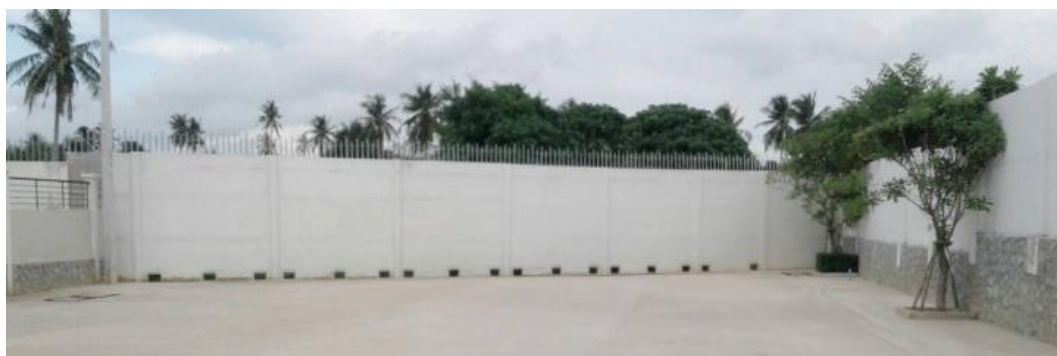
รูปที่ 3.19 ระบายน้ำภายในโครงการ
