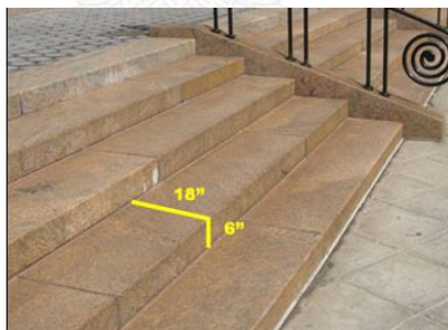
ภาพที่ 2 - 5 แสดงมาตรฐานการออกแบบประยะบันได
