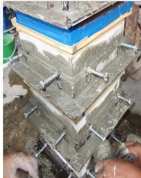
รูปที่ 3.9 ใช้ซีเมนต์เกรทอุดช่องว่างระหว่างเสากับ เหล็กรูปตัวที (RC-LS)
