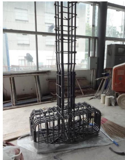
(ข) เหล็กเสริมเสาสะพาน
