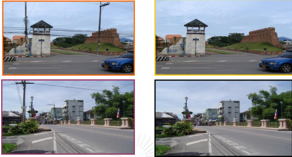
ภาพที่ 35 การปรับปรุงระบบสายไฟลงดิน ถนนราชดำเนิน
