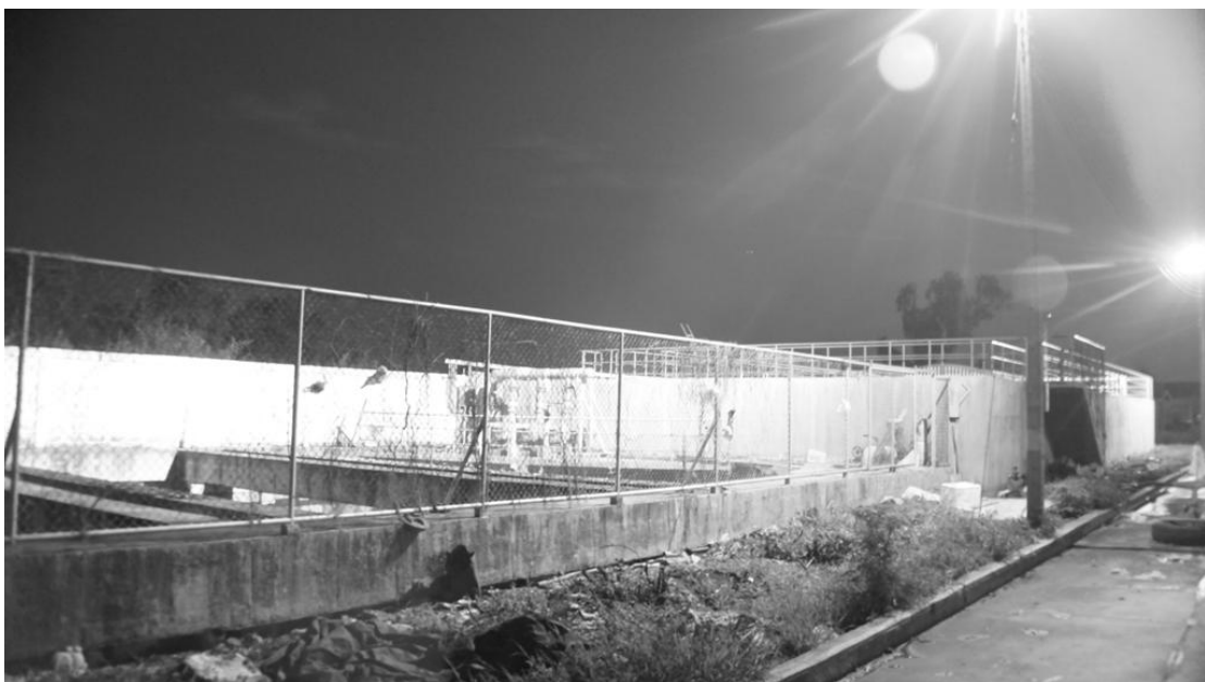
รูปที่ 4.8 บ่อบำบัดน้ำเสียภายในบริเวณตลาดไท
