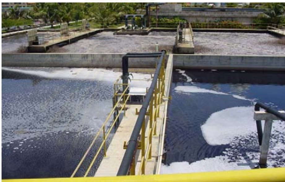
ภาพที่ 3.2 ระบบบำบัดแบบ AS ของโรงงาน
