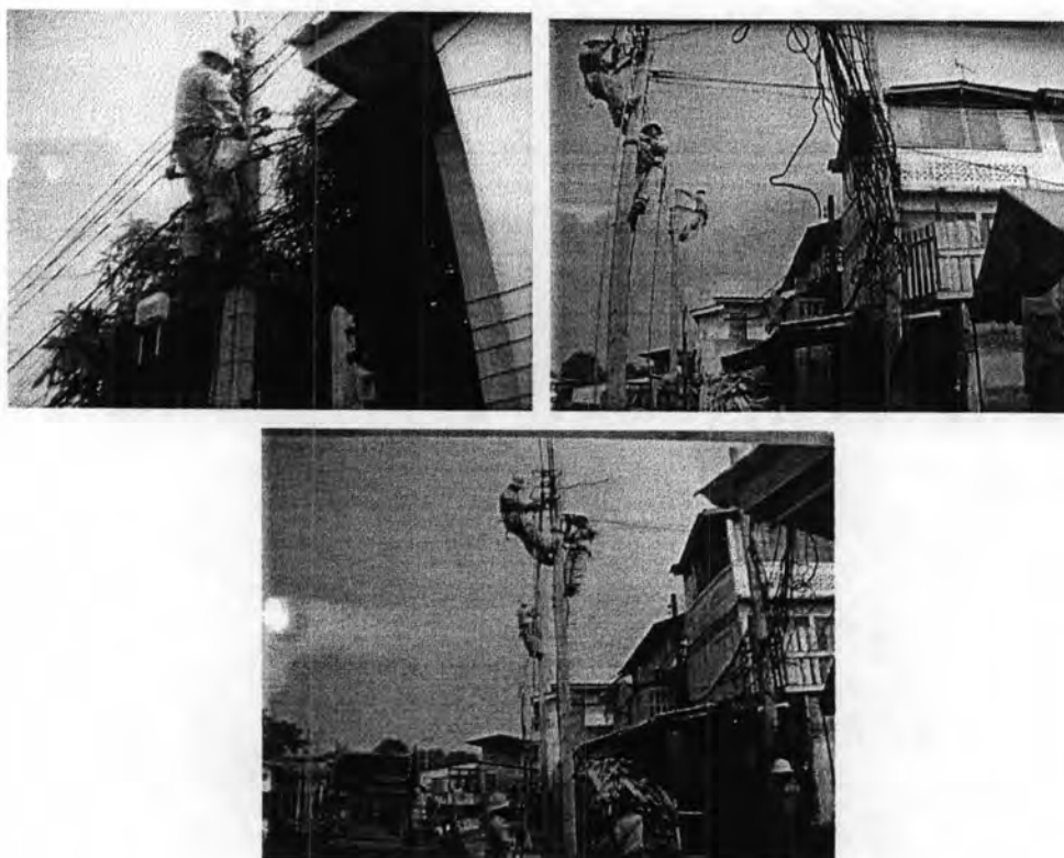
รูปที่ 5.13 การวางระบบสาธารณูปโภคภายในชุมชน
