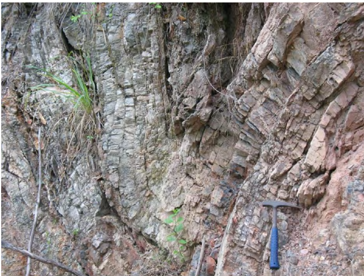
รูป 3.2 แสดงรายละเอียดของเนื้อหินเนื้อหินที่เปลี่ยนแปลงแบบแตกเปราะ โดยมีแนวรอยแตกวางตัวขนานและตั้งฉากกับแนวการวางตัวของชั้นหิน และ แนวรอยแตกมีการแทรกของสายแร่ควอตซ์ตัดผ่าน
