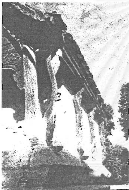
ภาพที่ 5.57 ลักษณะคันทวยอันเก่าที่เสียหาย
