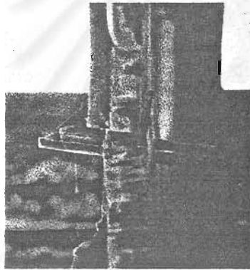
ภาพที่ 5.56 เทคนิคการยึดแผ่นไม้ส่วนฮังผึ่ง ที่วัดเสมาท่าค้อ
