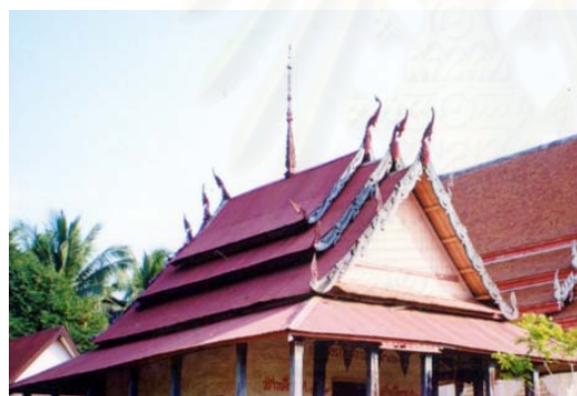
ภาพที่ 3.62 หลังจากการซ่อมครั้งสุดท้าย ก็มีการนำเอาสังกะสีมุงแทนวัสดุเดิม ที่ สิมวัดโพธิ์ศรี จ.ขอนแก่น
