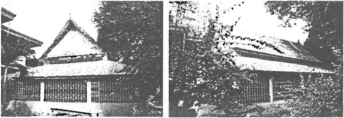
ภาพที่ 4.18 การเปลี่ยนแปลงการใช้งานของพื้นที่รอบอาคาร ของสิมวัดกลางโกสุม จ.มหาสารคาม เปลี่ยนแปลงการใช้งานโดยใช้พื้นที่รอบๆ ทำเป็นที่เก็บของ โดยติดเหล็กดัด ที่มาของภาพ: ลีราภรณ์ สิทธิันทวงศ์, เมษายน พ.ศ.๒๕๔๓
