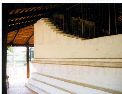
ภาพที่ 3.48 ช่องเปิดแบบขั้นบันได ที่ สิมวัดกลางโคกค้อ อ.ยางตลาด จ.กาฬสินธุ์
