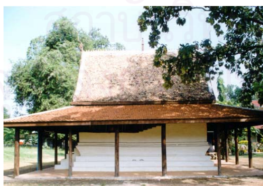
ภาพที่ 3.63 หลังคาสิม วัดกลางโคกค้อ จ.กาฬสินธุ์ ส่วนบนเป็นวัสดุแต่ดั้งเดิมคือกระเบื้องดินขอ ส่วนปีกนกเป็นวัสดุแบบเดิมแต่เป็นของใหม่ที่นำมาใช้ซ่อมเมื่อครั้งบูรณะครั้งสุดท้าย
