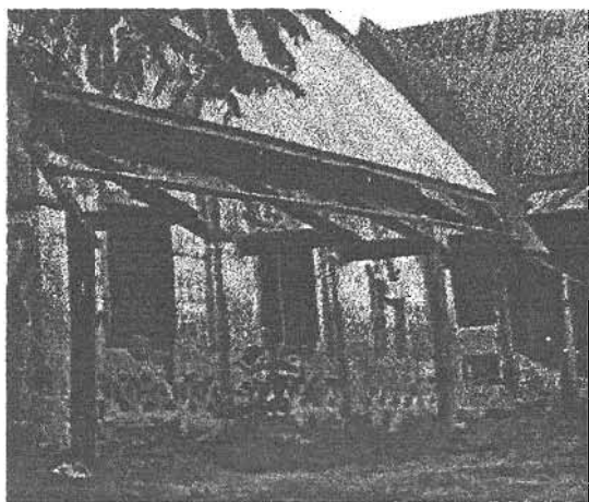
ภาพที่ 4.5 การนำสังกะสีมามุงแทน วัสดุเดิมคือ แป้นเกล็ดไม้ที่เสื่อมสภาพไป ส่วนปีกนกไม้ได้ซ่อมแซม คงเหลือแต่โครงไม้ ที่มาของภาพที่ 4.3, 4.4: ลิราภรณ์ สิทธิันทวงศ์, ตุลาคม พ.ศ.๒๕๔๒
