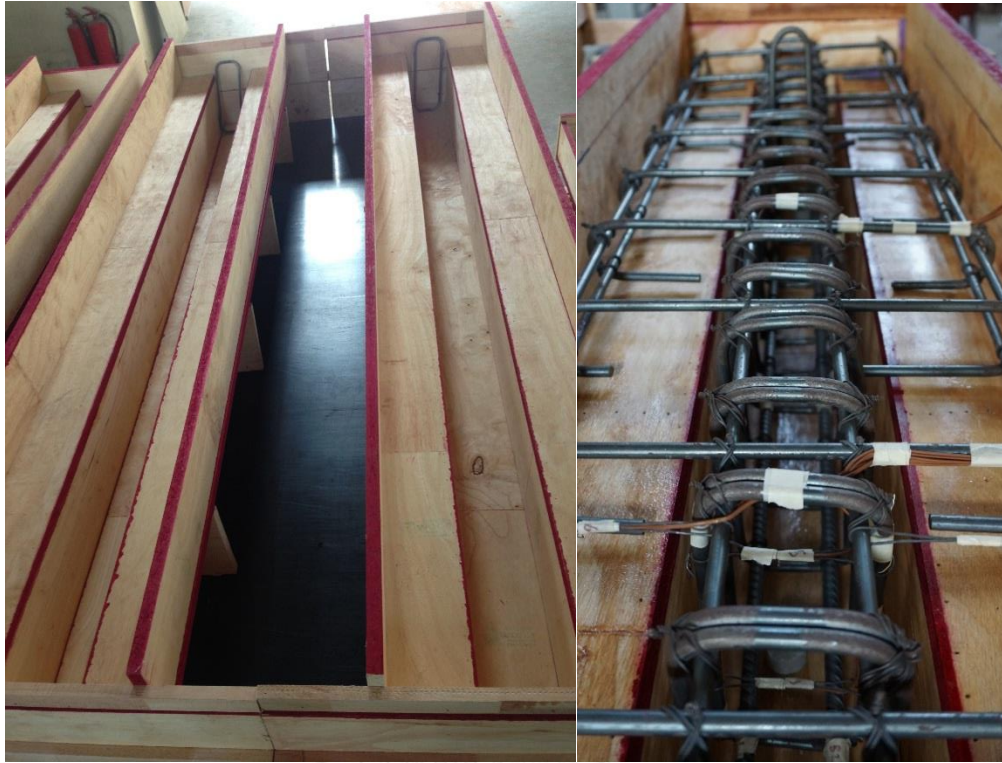
รูปที่ 4.2 แบบที่ใช้หล่อคานตัวอย่าง แบบหล่อคานตัวอย่างใช้เป็นไม้อัด ซึ่งทำการยึดไว้ด้วยลวดตะปูและทำการติดป้ายบอกชื่อตัวอย่าง เพื่อป้องกันการสับสนดังรูปที่ 4.1
