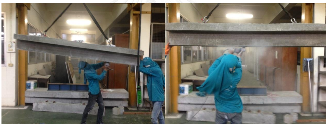
รูปที่ 4.30 การเตรียมผิวสำหรับติดตั้งแผ่นพอลิเมอร์
