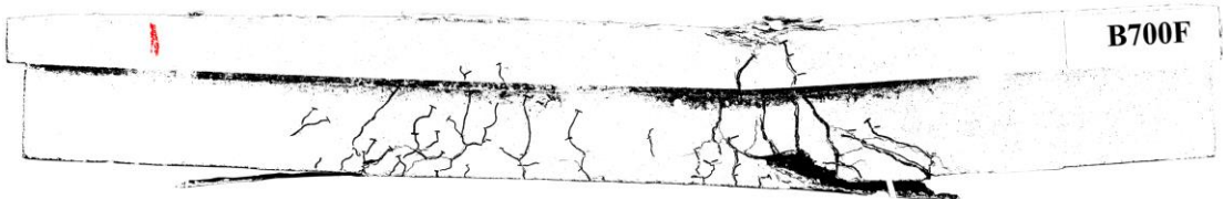
รูปที่ 5.107 คราบเคลือบคาร์บอนและรอยแตกร้าวที่เกิดขึ้นที่การวิบัติของคาน B700F (ไม่มีน้ำหนักบรรทุก)
