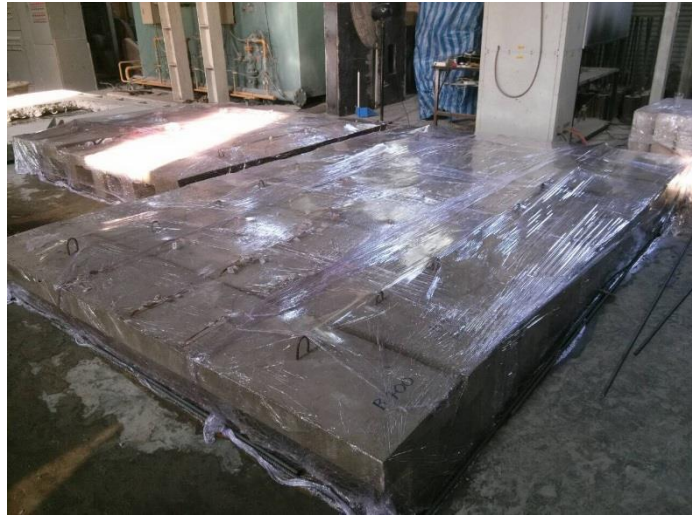
รูปที่ 4.4 การบ่มคานคอนกรีตภายหลังถอดแบบโดยใช้พลาสติกใส
