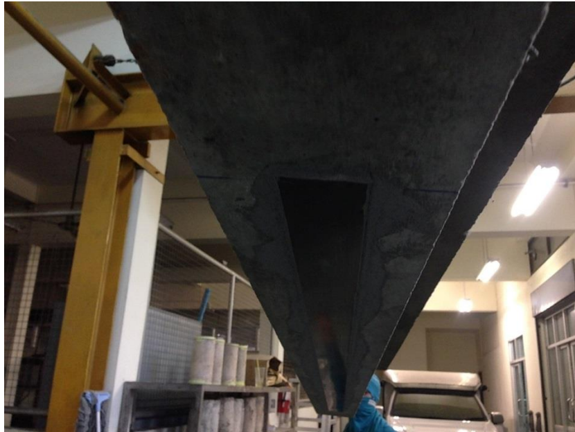
รูปที่ 4.32 แผ่นพอลิเมอร์เสริมเส้นใยคาร์บอนที่ถูกติดตั้งกับคาน
