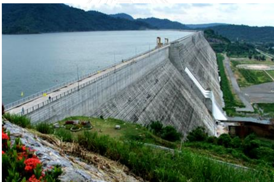
รูปที่ 2-8 เขื่อนคลองท่าด่าน จังหวัดนครนายก
