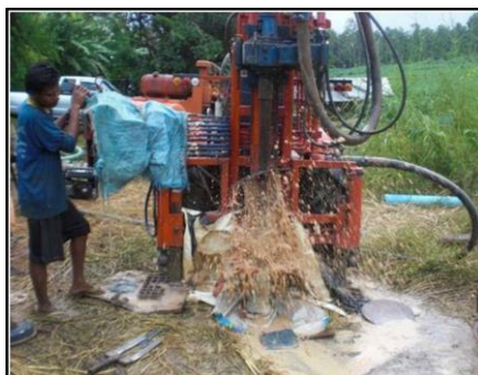
ภาพที่ 43 การเจาะบ่อน้ำบาดาล
