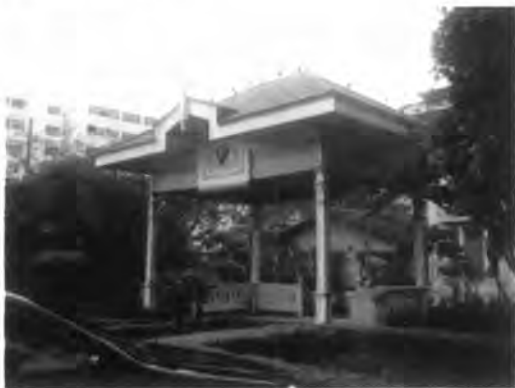
รูปที่ 5-80 ศาลาริมคลองที่มีชานลดระดับยื่นไปยังคลอง
