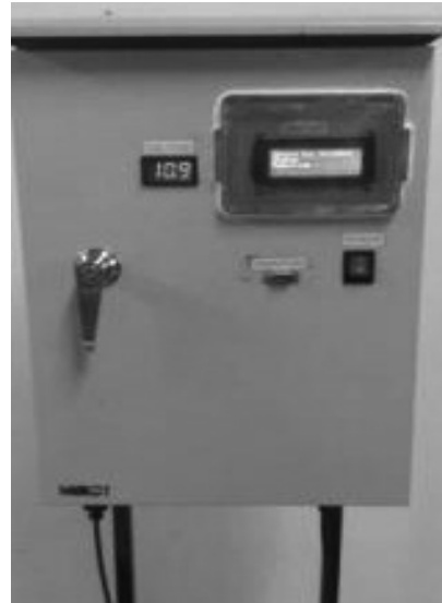
ข. ตู้ควบคุมภายนอกของระบบประมวลผลส่วนกลาง
