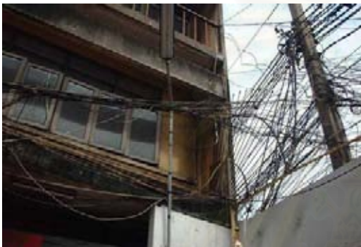
ภาพประกอบที่ 4 - 14 และ 40 - 15 แสดงสภาพสายไฟฟ้าระโยงระยาง
