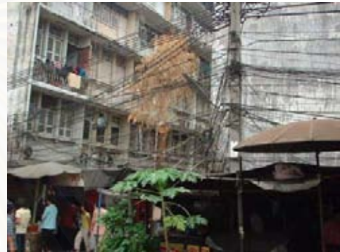
ภาพประกอบที่ 4 - 14 และ 40 - 15 แสดงสภาพสายไฟฟ้าระโยงระยาง
