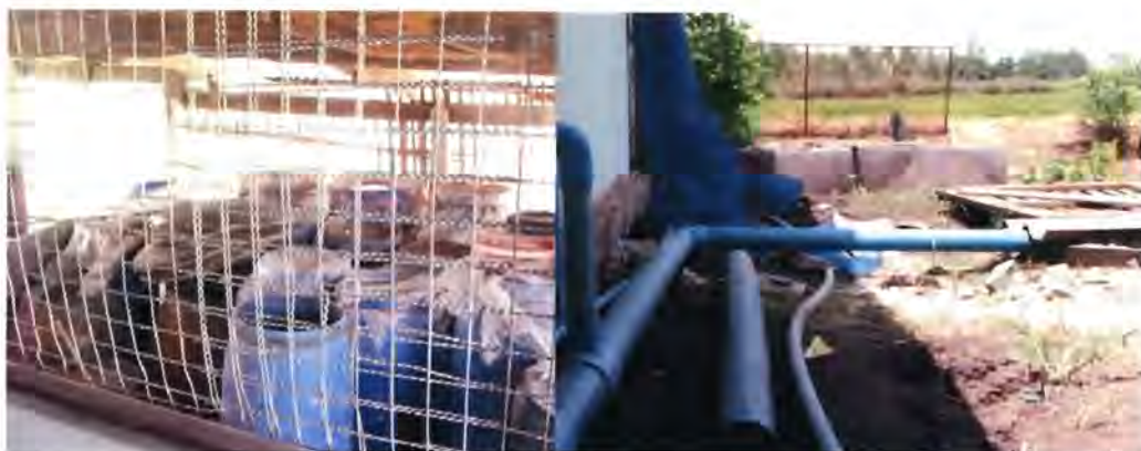
รูปที่ 23 ห้องคองผลไม้และบ่อพักน้ำเสียที่เปลี่ยนตำแหน่งไป
