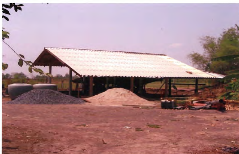
รูปที่ 16.1 อาคารใหม่ที่สร้างค้างอยู่
